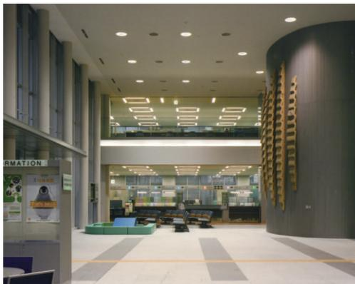
市民ロビーの照明 金属ハイドランプダウンライト電動昇降装置付きを採用
