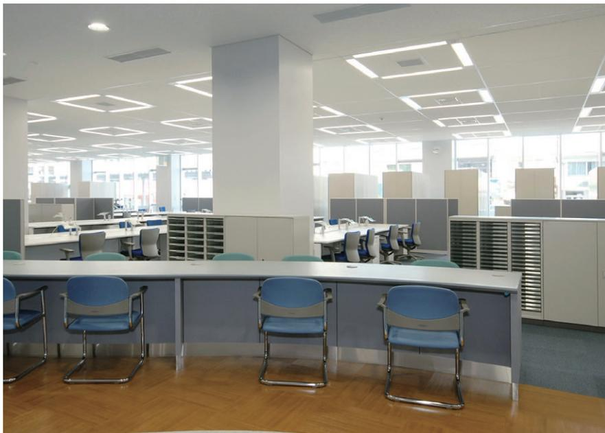
1階執務室市民窓口の照明 システム天井用器具口形配置とし、照度センサとの連動により、750lxを確保しつつ、初期照度補正制御と昼光利用制御を行い、省エネを図っている
