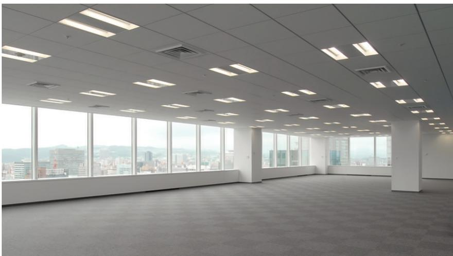
オフィス基準階の照明 600モジュールグリッド天井システム器具を採用
