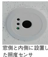
窓側と内側に設置した照度センサ
