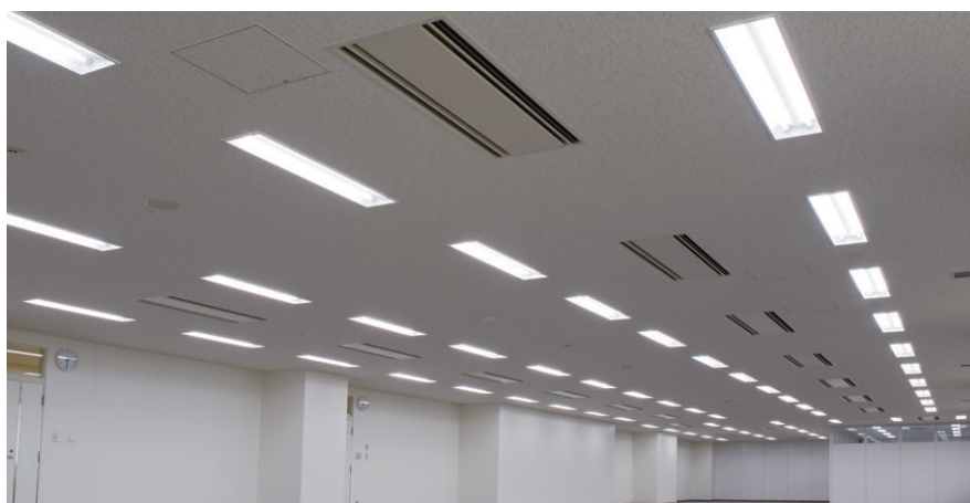
執務エリア Hf32W2灯用埋込形システムアップ器具を全室に採用。照明制御装置MESLとの連動により、グループ制御、パターン制御など業務内容に合せた照明制御を行う
