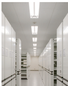
書庫 ステンレス製スライド書棚が置かれた書庫。動線上に照明器具を配置して床面の明るさを確保している
