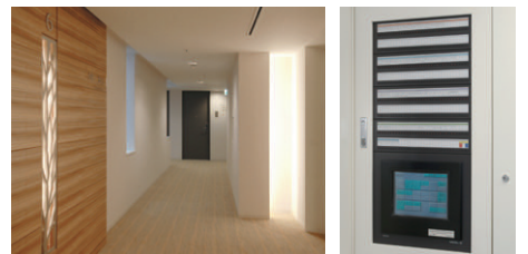
ホテル廊下の照明
