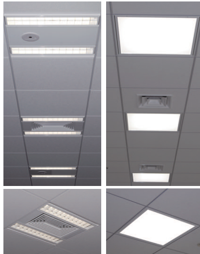
執務室には、グリッド天井システム、FHP45W×2ルーバ付 打合せ・相談コーナーにはグリッド天井システム FHP45W×3カバー付
