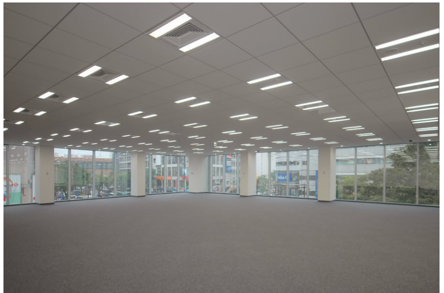
1階から4階のオフィスの照明はグリッド天井システムスクエア器具を、執務室にはFHP45×2を、打合せコーナーにはFHP45×3を採用
