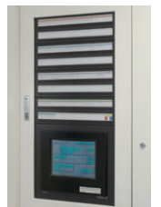
照明制御装置主操作盤 (MESL-S)
