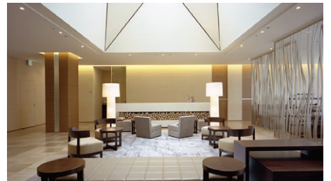
ホテルフロントロビーの照明 ダウンライトと間接照明を主体 (撮影/吉村 行雄)
