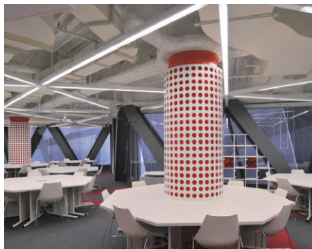
グラフィックデザインルーム 特注トラフ器具ルーパ付きを採用
