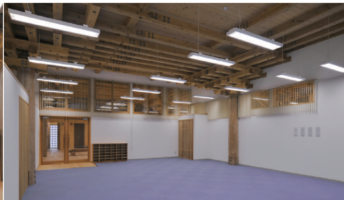
コンピュータ教室の照明 ワイヤ吊スクールソフトバツフル付を採用しPCモニタ映り込みを防止
