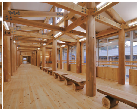
2階廊下・ワークルーム Hf32W1灯用トラフを横付設置し、空間を明るくしながら天井構造体を明るく照射
