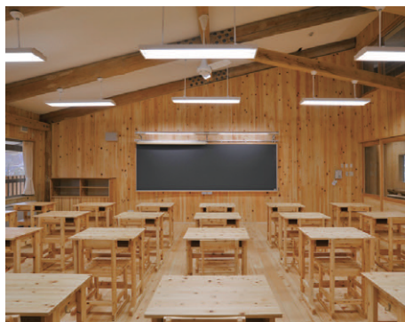
2階普通教室の照明 上方向にも光が回るスクールソフトパイプ吊りを設置
