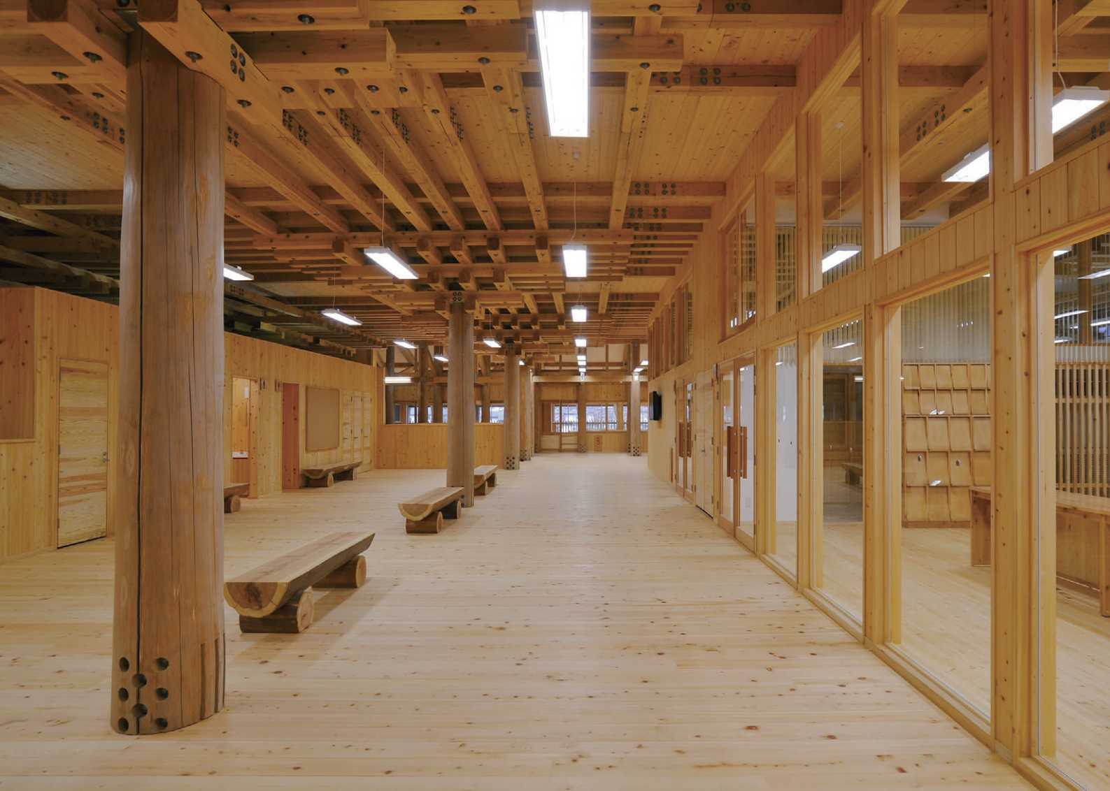
木材による大断面軸組工法の大空間が形成されているふれ合いホールの照明 Hf32W2灯用ワイヤ吊りのスクールソフトを採用。空間全体を明るくし対比を柔らげて快適な視環境を確保
