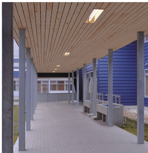
渡り廊下の照明 Hf32W1灯用防湿防雨形トラフによる建築化照明
