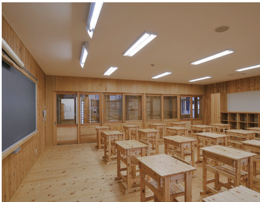
1階普通教室の照明 Hf32W2灯用教室専用直付器具（スクールソフト）を整列配置、視野内にグレアの少ない光環境を確保
