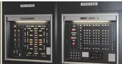
照明点灯調光操作装置（左）と昇降操作装置（右）
