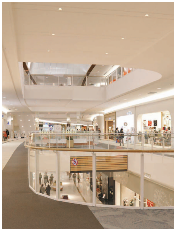
ブリッジ天井部に長寿命を生かしてE-CORE〔イー・コア〕LEDダウンライトを採用。ランプ交換の低減を図っている
