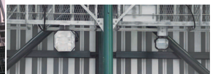
銀傘下に設けられた清掃用の400Wメタルハライド投光器（左）と保安用の500Wハロゲン投光器（右）
