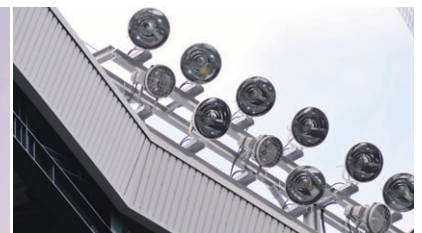
耐衝撃対策が施された内蔵ルーバ付の高反射高効率化Tブライト投光器と瞬時再始動形投光器
