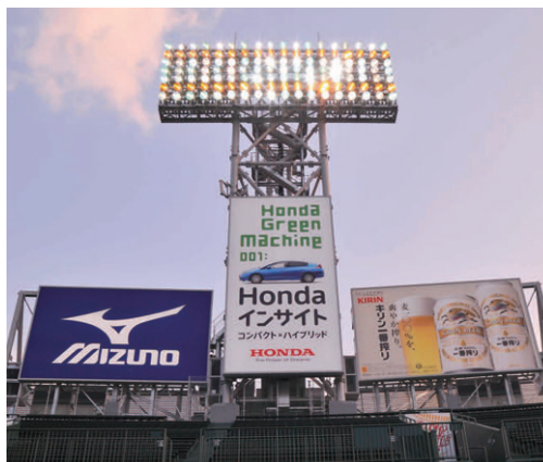
高演色形メタルハライドランプと高圧ナトリウムランプとで混光された照明塔と内照式アボード3面（調光制御可能）
