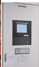
照明制御システム (MESL-S) 主操作盤
