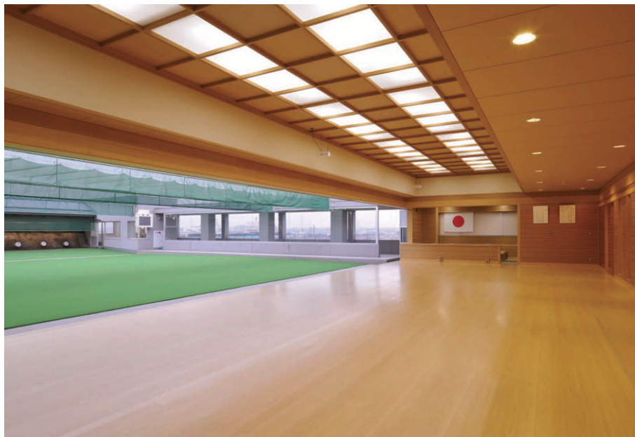
弦音がみだれない設計・施工とした弓道場射場の照明 乳白アクリルカバー付 (FHF32W1灯用トラフ)を使用した和風建築化照明
