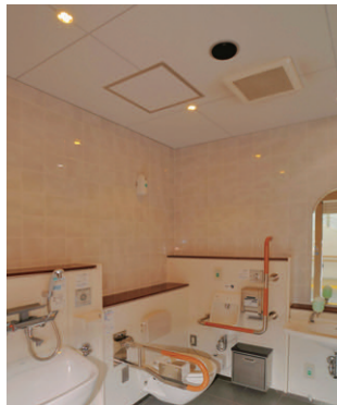
多目的トイレのLEDダウンライト
