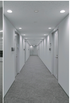
中央廊下のLED照明
