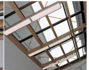
階段上の天井に設置されたLEDベースライトストレートタイプ2連結
