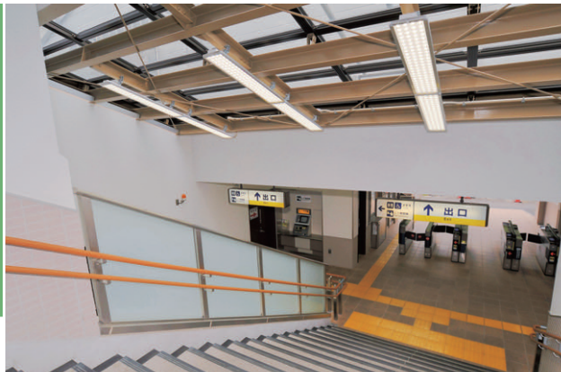
コンコースの階段にLEDベースライトストレートタイプを2連結にして3列配置
