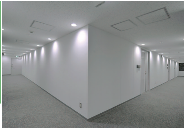
T字廊下のLED照明 壁面にも柔らかく照射し、廊下全体を明るくしている
