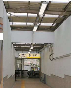
通路の天井中央に1列にして配置
