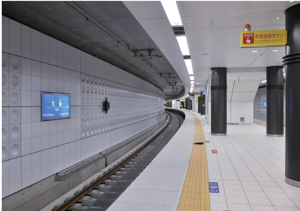
プラットフォーム端の照明 FHF86W高反射塗装器具で安全性を高めた明るい光環境
