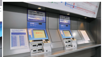
券売機の照明（LEDダウンライトE-CORE300クラス）
