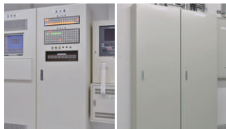
照明主操作盤 (MESL-S)
