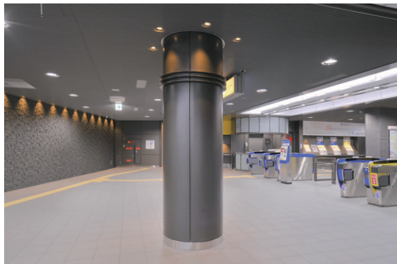
西口の内コンコースの照明 ベース照明はFHT42W×2ダウンライト、壁面、柱にはLEDダウンライト（E-CORE300クラス）で光のアクセントを形成
