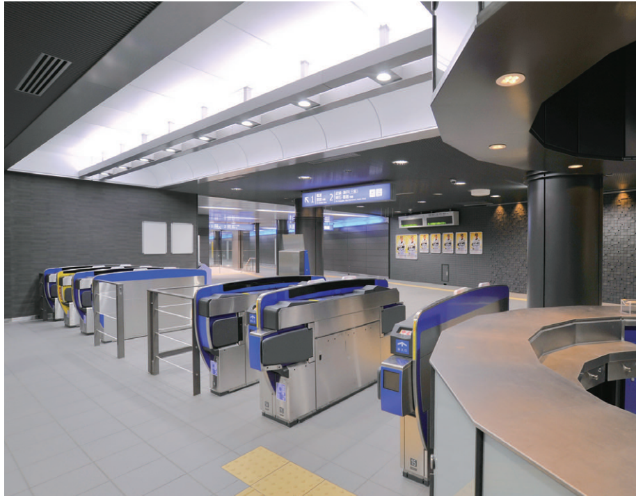
西口改札口の照明 R状天井にFHF86Wによる間接照明、自動改札機へはLEDダウンライト（E-CORE900クラス）で局部照明
