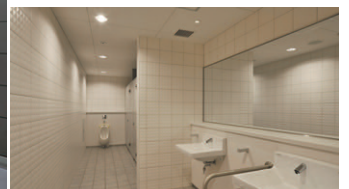
トイレの照明 LEDダウンライトとセンサの連動で人がいないときは自動消灯
