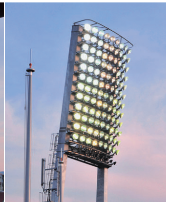
照明架台に12段×9列にして設けられたHID投光器
