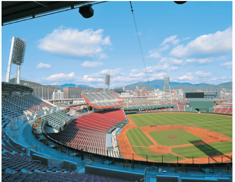
2階正面観客席よりスコアボード方向を望む昼景。約48～56m高さの照明塔6基による全周配置を採用
