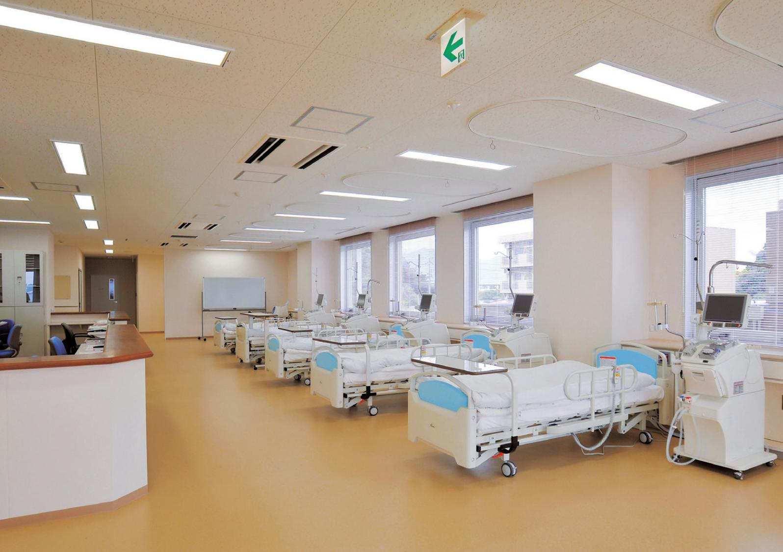
透析室の照明 FHF32W×2乳白カバー付埋込器具調光形を使用し、拡散光で柔らかく眩しさを軽減
