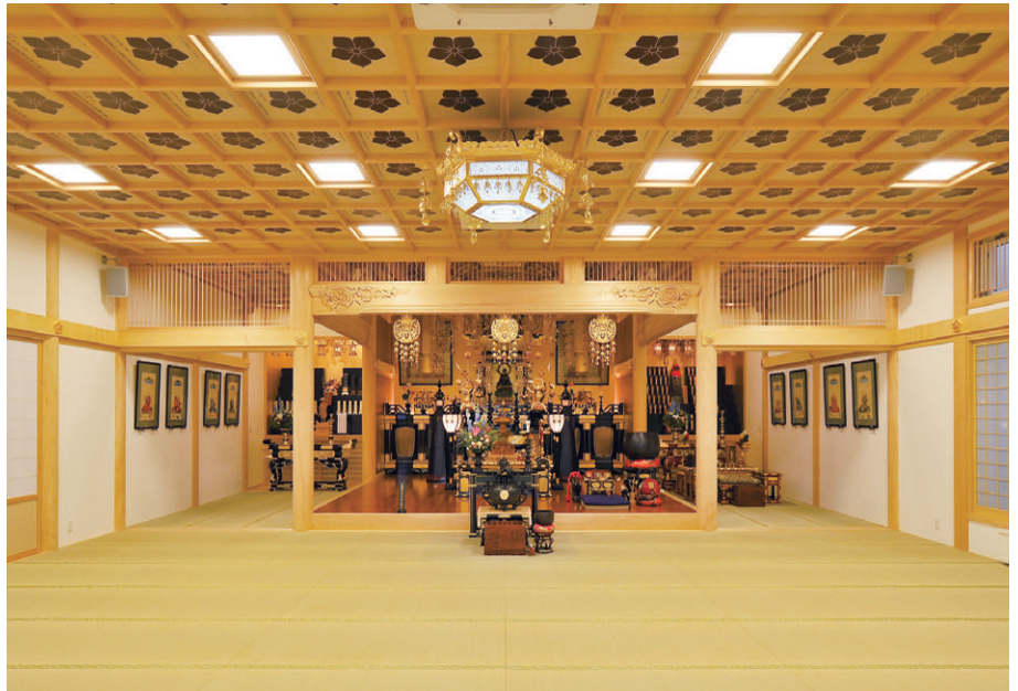
格天井の外陣照明 FHP32W3灯用和風スクエア器具を採用。段調光でフレキシブルな明るさを確保
