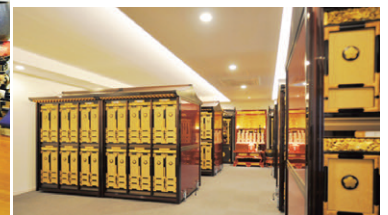
納骨室の照明 間接照明を中心に随所に蛍光灯ダウンライトを配置
