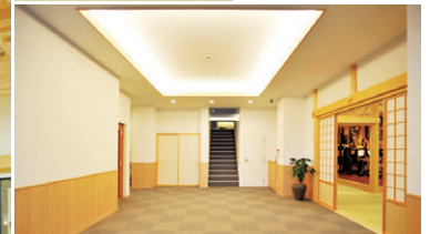
間接照明を主体としたロビーの照明
