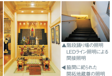
格天井の外陣照明 FHP32W3灯用和風スクエア器具を採用。段調光でフレキシブルな明るさを確保
