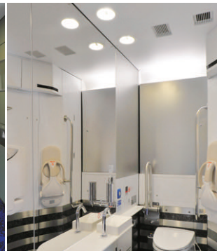
トイレの照明 (FDL18Wダウンライト) と 洗面所の照明 (FDL18Wダウンライト) 間接照明
