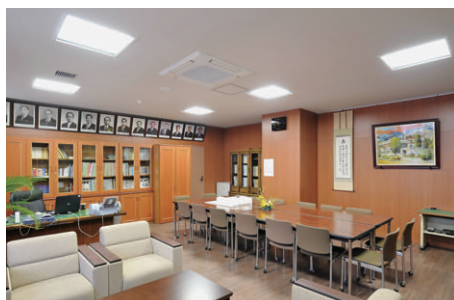
校長室にはFHP45W4灯用埋込深枠器具を採用
