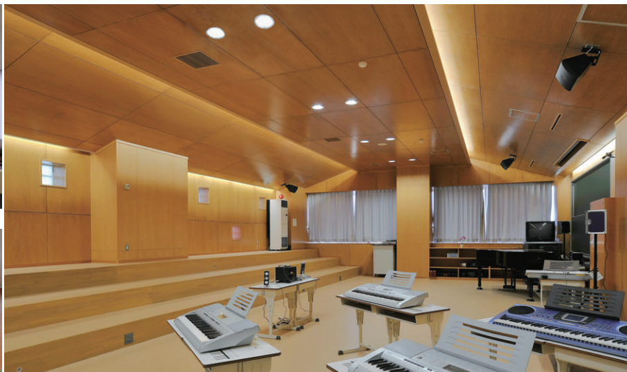
音楽教室の照明 間接トラフとFHT42W2灯用ダウンライトを設置
