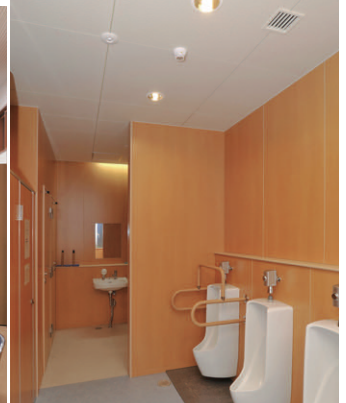
FHT32W人感センサ付ダウンライトをトイレに採用
