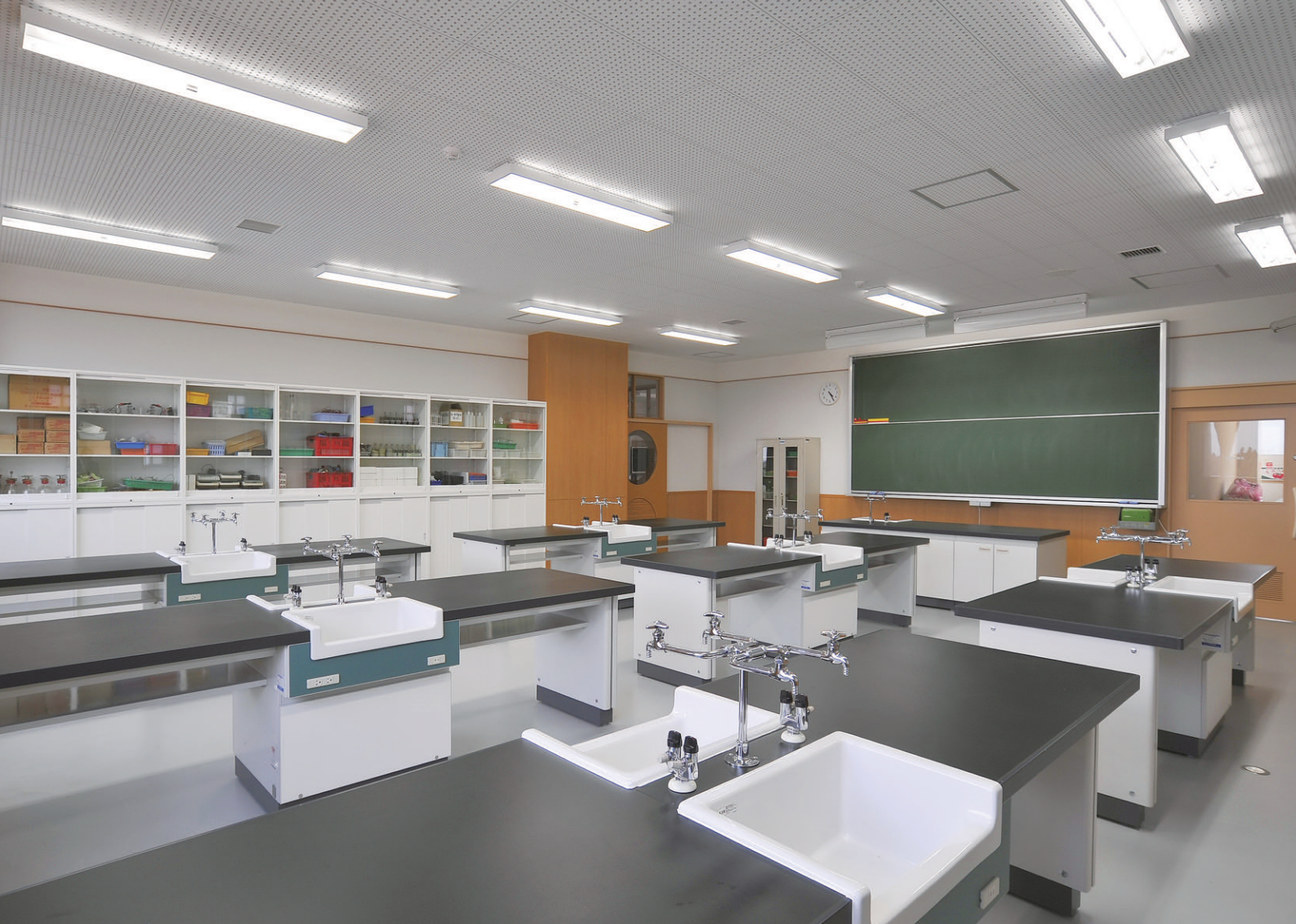
理科教室の照明 FHF32W2灯用楽エコSESLスクールソフト直付形(下面開放)を採用し、目に優しい視環境を得ながら余分な明るさをカットして省エネ
