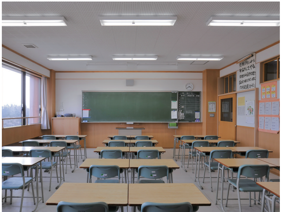
普通教室の照明 楽エコSESLスクールソフト直付形(下面開放、FHF32W2灯用)を黒板と平行に均等配置
