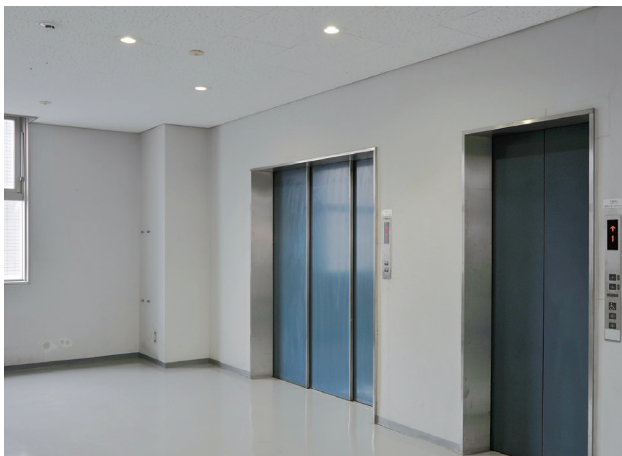
工学部1号館のエレベータホールの照明 LEDダウンライト900シリーズと人感センサで人の動きを検知して点滅制御
