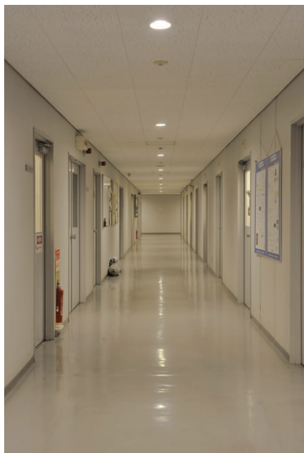
工学部1号館の廊下の照明 LEDダウンライト900シリーズと人感センサで点滅制御
