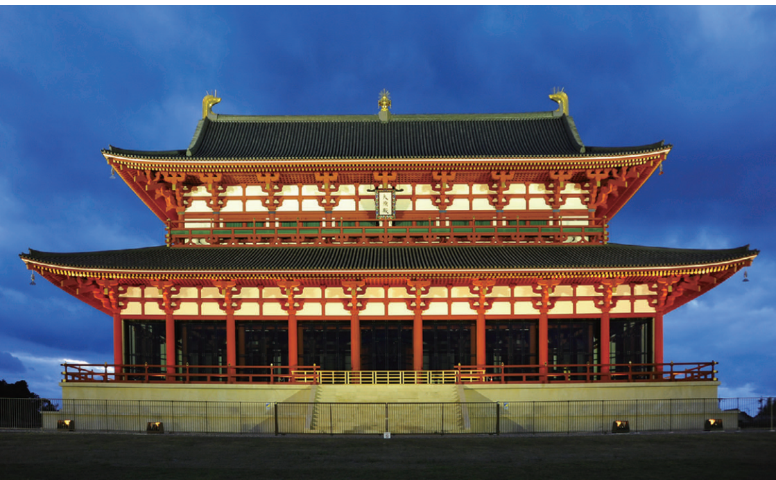
大極殿の正面地明かり照明として、400Wメタルハライドランプ超狭角形投光器を東側と西側の前方二方向より照射して白壁を浮かせている。朱色塗装の軒裏及び柱には400W高演色形高圧ナトリウムランプ狭角形投光器により自然な色合いを再現
