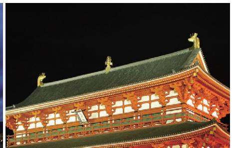
屋根上の金属製鷲尾及び大棟中央飾りへのスポットライト
