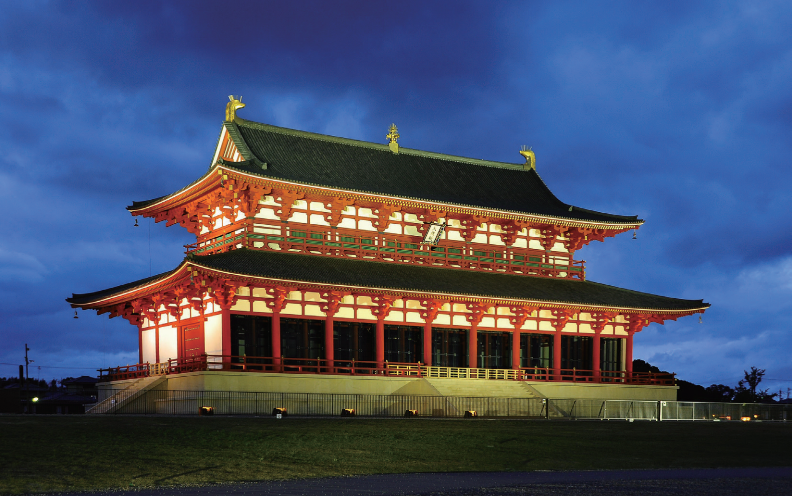
西側前方寄りから望む大極殿のライトアップ。白壁への投光照明はメタルハライドランプ、朱色の軒裏及び柱への投光照明は高圧ナトリウムランプにより、ほどよい色味で調和
