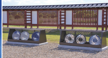
建物側面用地明かり照明の超狭角形投光器と破風用超狭角形投光器
