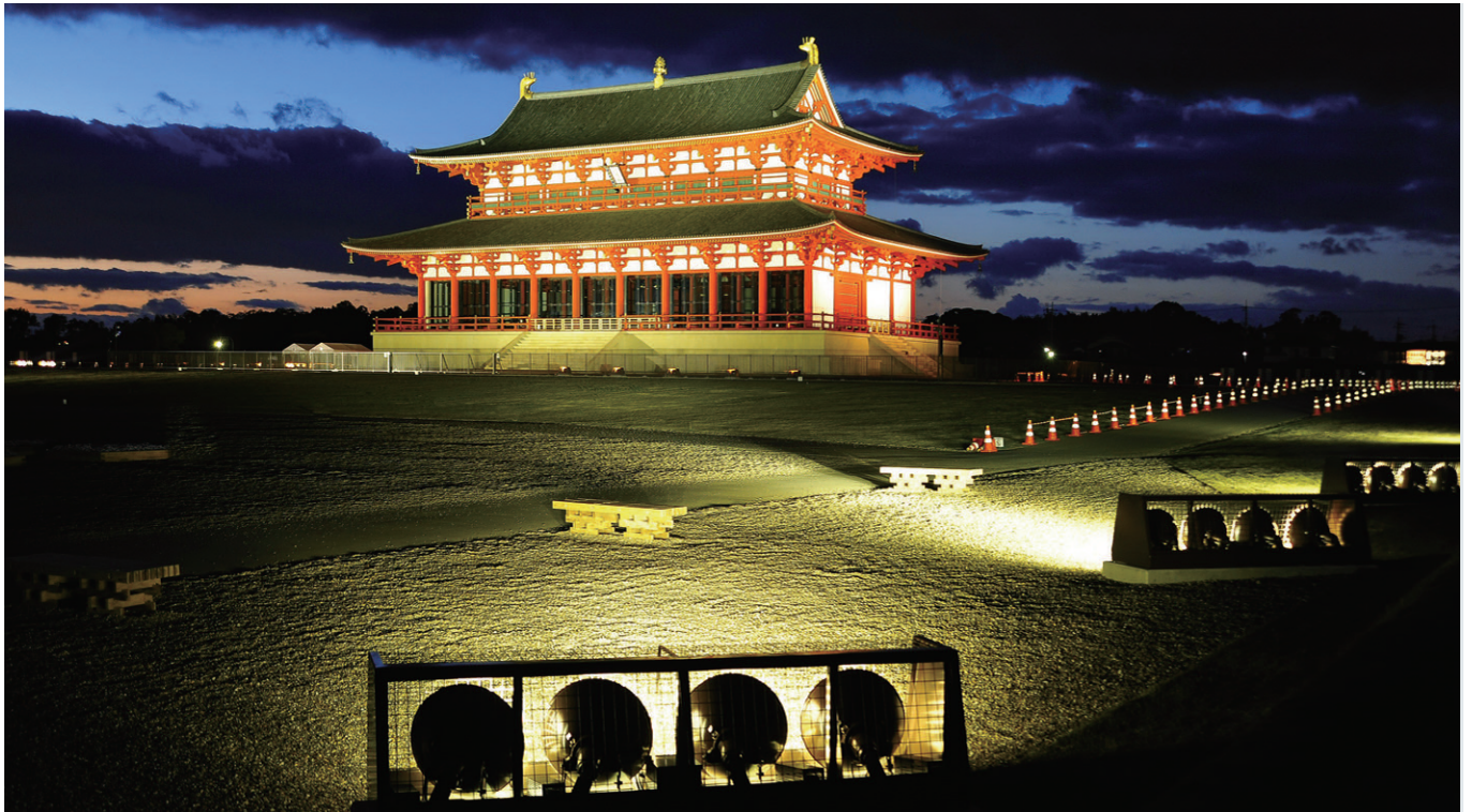
地明かり照明のそれぞれの投光器は、来訪者の妨げにならないように建物や前庭を囲む築地回廊近くの地面に照明ボックスに納めて設置
