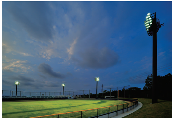
照明柱6基(高さ約29.1m)によるナイター設備をライト側客席からグラウンドを望む
