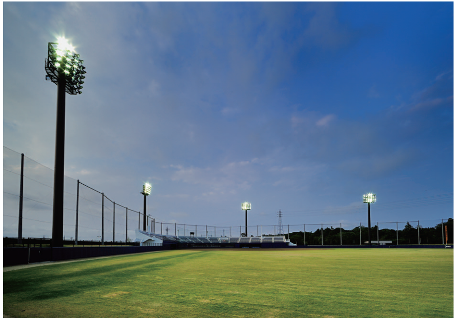
ライト側客席からグラウンドを望むナイター設備。照明柱1基当たり5段×6列で高演色・高効率の1kWメタルハライドランプルーバー内蔵投光器(キャドミラーA)を設置
