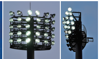
30台の投光器とその後方に設置した電撃殺虫器
