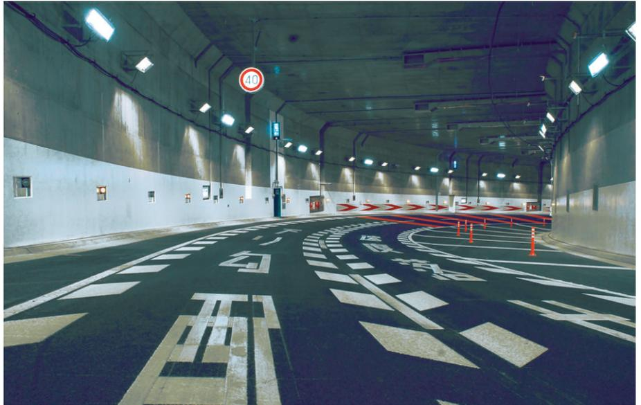
基本照明にHf32W2灯用器具を使用し、追跡照明にはセラミックメタルハライドランプ枠なしプレス形トンネル照明器具を採用
