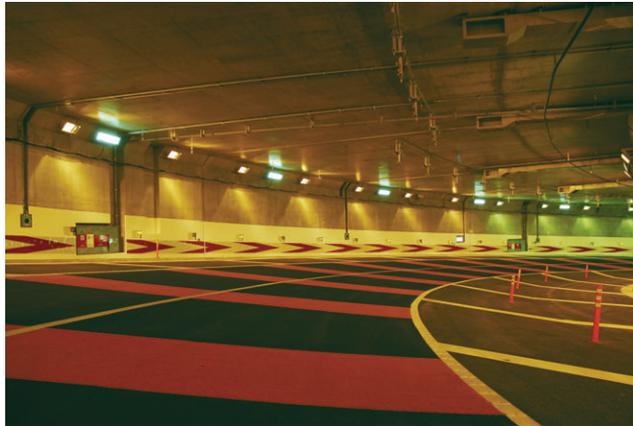
分流部の追跡照明には高圧ナトリウムランプ枠なしプレス形トンネル照明器具を採用
