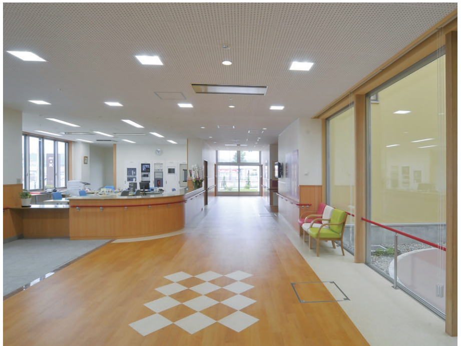
玄関ホールの照明 正面に配置された光庭からの緑や自然採光を損なうことのないよう照明は小形スクエア器具を配置
