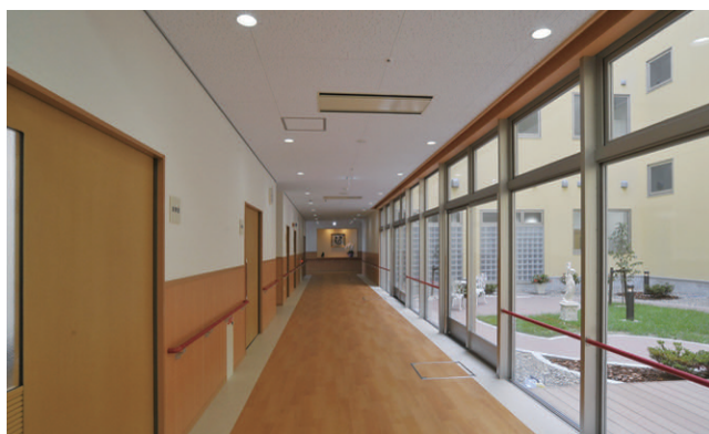
廊下はLEDダウンライト調光形を採用。省電力に加え、状況(昼間、夜間、深夜、天候)に合わせて細かな調光制御が可能。停電時には非常用発電機により点灯(写真は調光状態)
