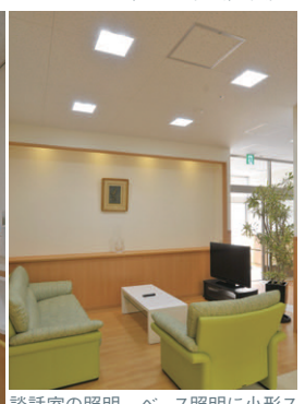
談話室の照明 ベース照明に小形スクエア器具、壁面にはLEDユニバーサルダウンライトを設置
