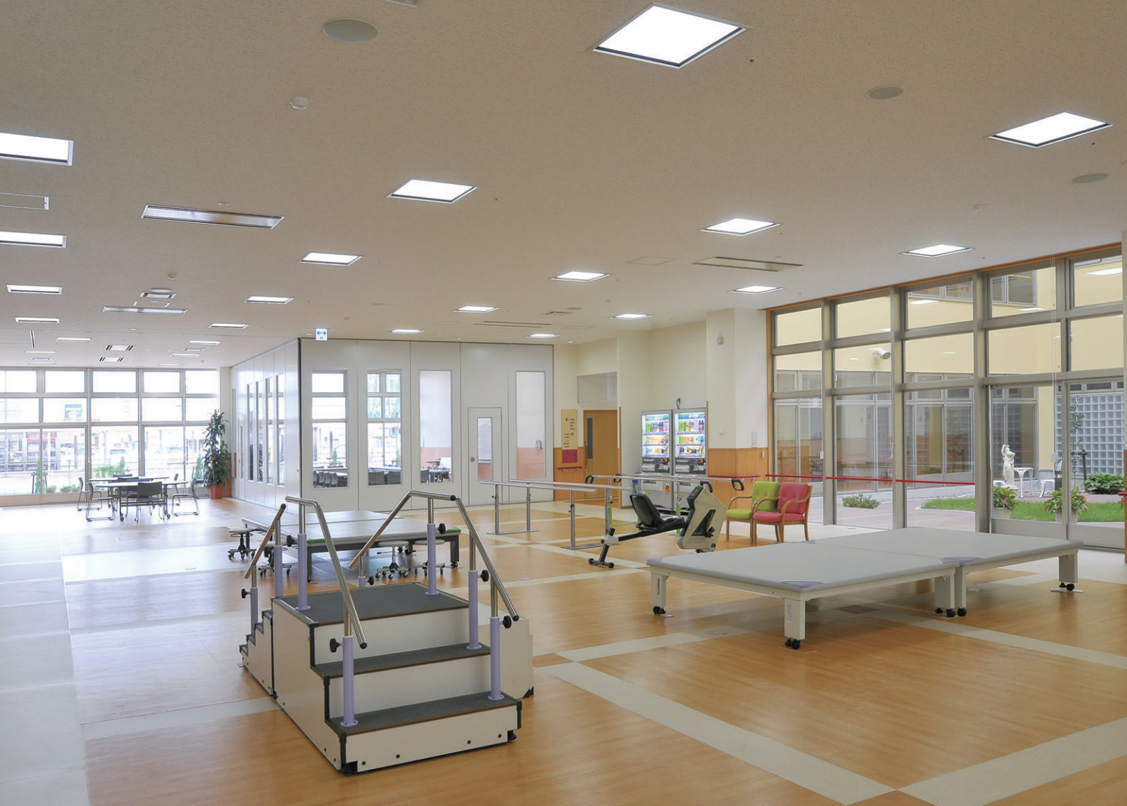
機能訓練室の照明 FHP45W4灯用深枠形埋込器具(調光形)を均等配置。35%~100%の連続調光で消費電力を削減
