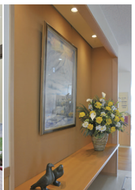
随所に設けた飾り棚にはLEDユニバーサルダウンライト(電球色相当)を設置
