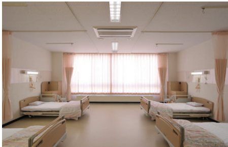
療養室4床部屋の照明 ベースには病室用照明器具(ホスピタルソフト)を採用
