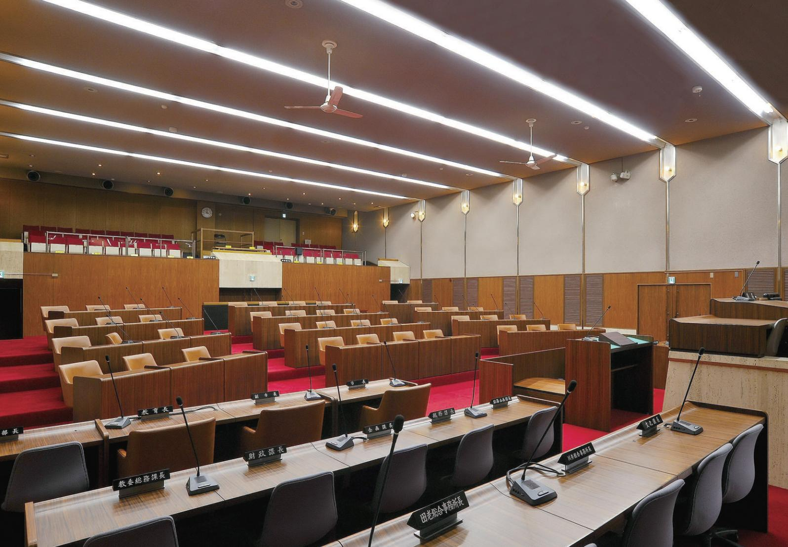
議場の照明 天井スリット内に設けられていたFLR110W1灯用トラフをFHF86W2灯用トラフに更新。壁面の既設60W白熱灯も6.9W一般電球形LED電球に更新し、同等以上の明るさを確保しつつ大幅な省エネが図られている
