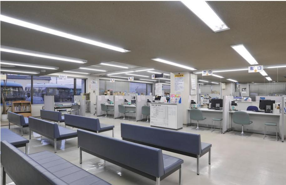
総合窓口の照明 FHF86W1灯用直付下面開放器具キャンピスイッチ付を採用し、不在時の無駄な明るさを細かにカット
