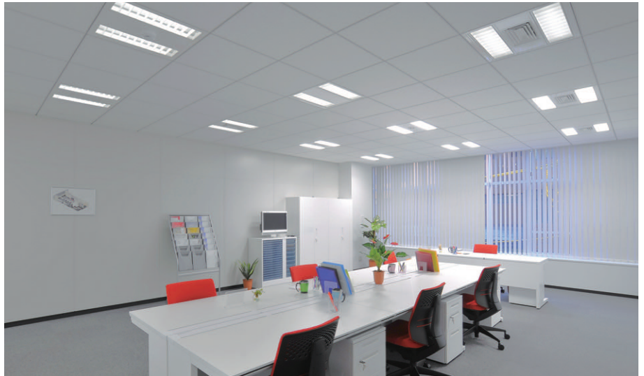
オフィス室内の照明 FHP45W2灯用グリッドシステム天井用器具バツフル付を縦・横1.8mピッチで配置して、明るく開放的な空間をつくり出している
