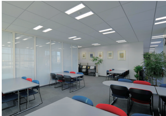
打合わせ室の照明 光の方向性がないグリッドシステム天井用器具の採用で、すっきりとした印象に仕上げられた天井面
