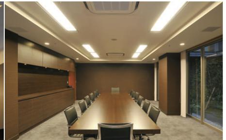
会議室の照明 32W Hf蛍光ランプ2灯用埋込器具深枠形と間接照明、平天井にはダウンライトを配置
