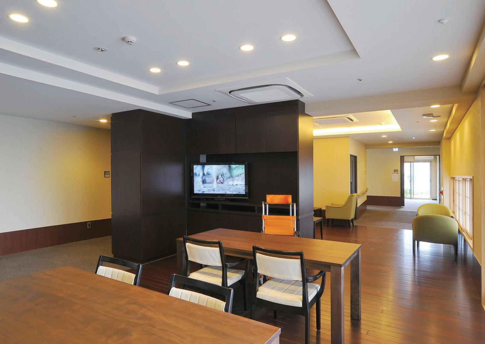
リビングルームの照明 折上天井面にLED電球一般形ダウンライトを配置し、集う場を際立たせるようにテーブル面の明るさを確保
