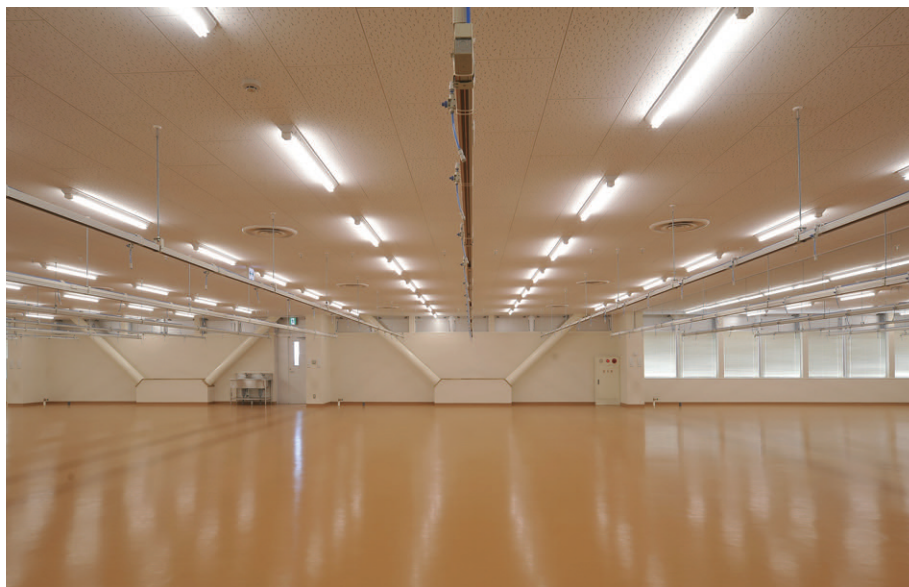
作業部門にはエネカット105 1灯用直付器具を採用。整列配置の千鳥配列とし、高精度の作業に対応した明るさと同時に省エネを実現
