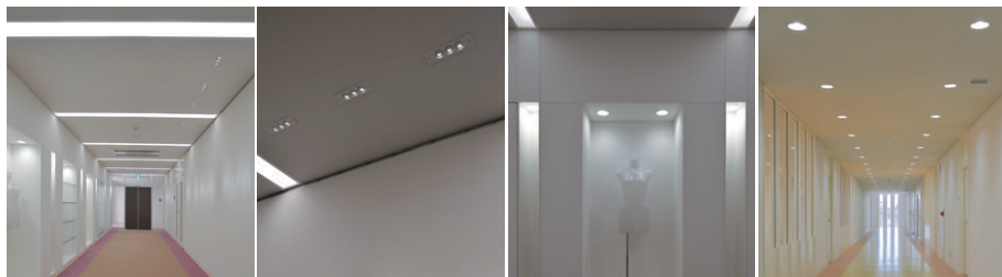
建築化照明によるエントランスの照明 エントランス壁面にはLEDユニバーサルダウンライトを使用 エントランス壁面内部の展示コーナーにはLEDダウンライトを設置 生産部門の廊下にはLEDダウンライトを採用
