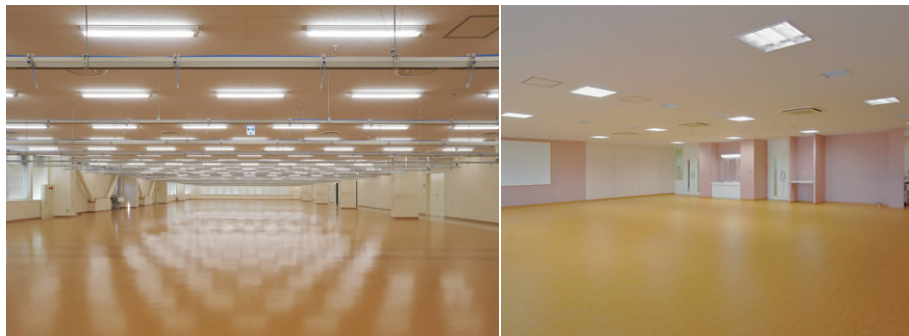
検査部門にはエネカット105の2灯用直付器具を採用し、細かい品質チェックできる明るさを確保 FHP45W4灯用埋込スクエア器具が採用されている食堂に品質チェックできる明るさを確保
