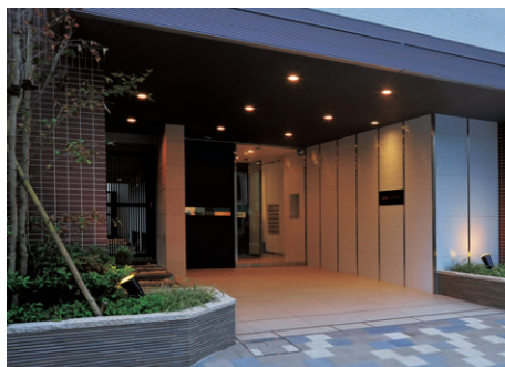
アプローチ(軒下)の照明 軒下用SGI形LEDダウンライトを採用
