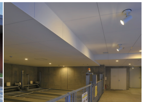
屋内駐車場の照明 地あかりのLEDダウンライトと局部照明のLEDスポットライトを採用
