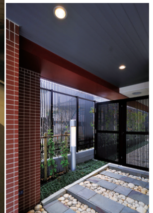
アプローチ脇に設置されたLEDガーデンライト
