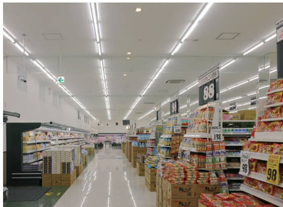
菓子コーナーの照明 ベース照明の間にユニバーサルダウンライトを配置
