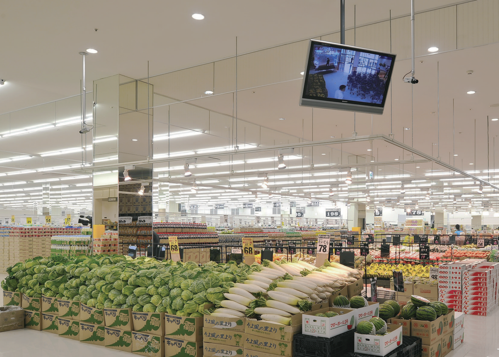
野菜売場コーナーの照明 高い天井でも対応できるLEDダウンライト6000シリーズを採用し、局部照明にはLEDスポットライトを床より2.5m位置に設置
