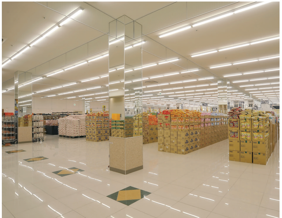
店内中央の売場エリアの照明 省エネ形蛍光灯直付器具「エネカット105」2灯用連結器具調光形を2.2mピッチでライン配置
