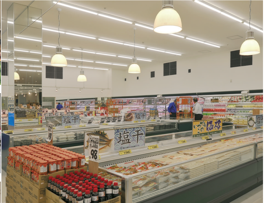
冷凍食品売場の照明 ベース照明のエネネット105のほか、局部照明に45Wコンパクト形蛍光灯3灯用口付ペンダントを採用
