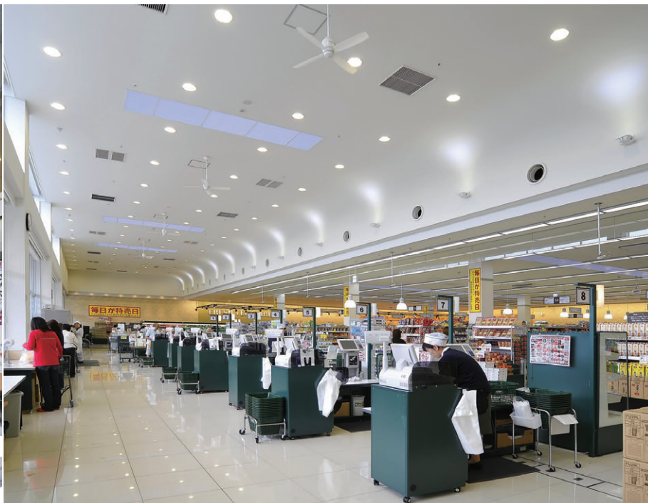
レジ周りの照明はFHTダウンライト電動昇降装置付を採用し、和みの雰囲気と省メンテを実現
