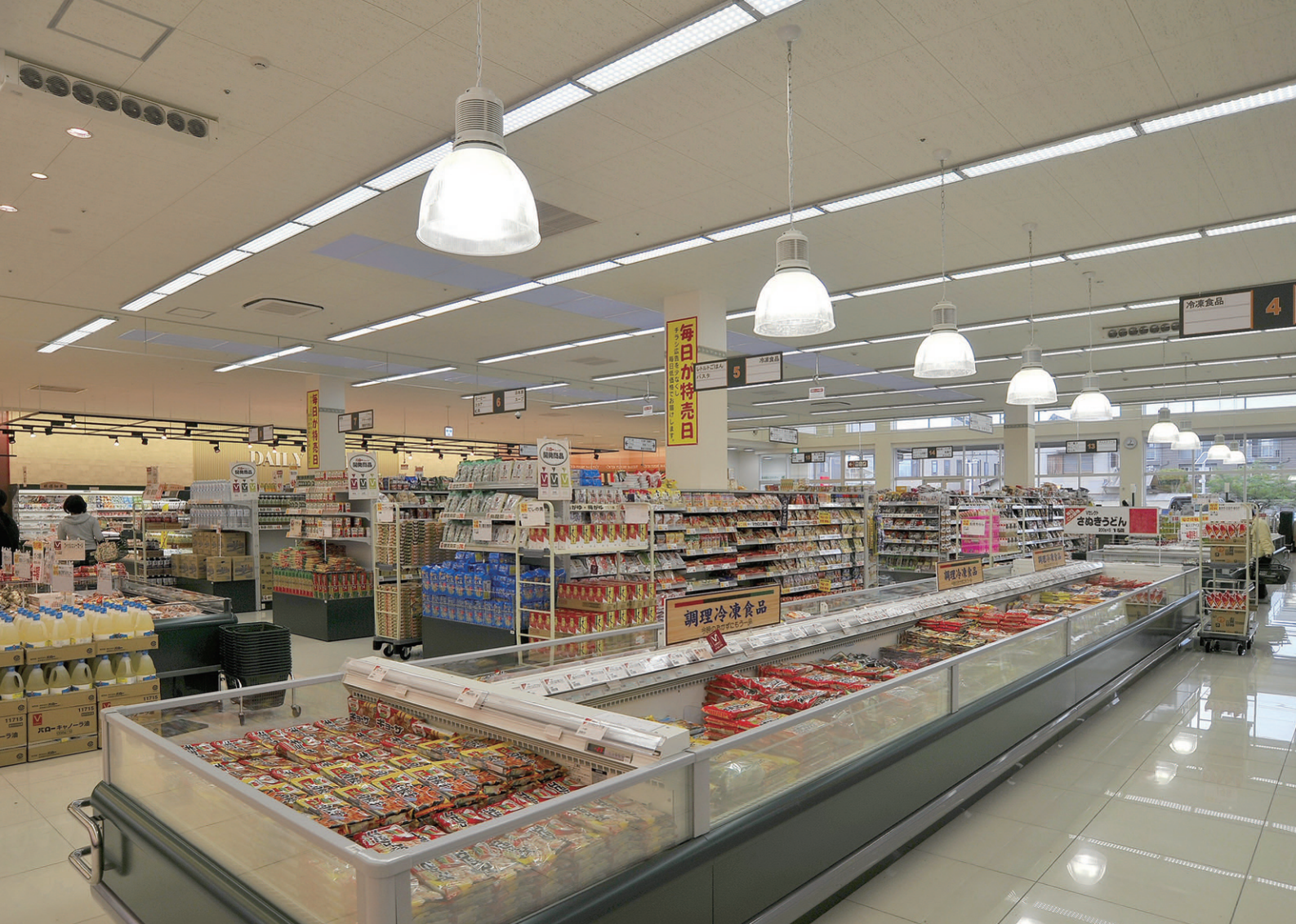
冷凍食品売場にはLEDベースライトストレートタイプ直付形のほかFHTロフトペンダントを採用し商品を明るく際立たせ、見分けやすくしている
