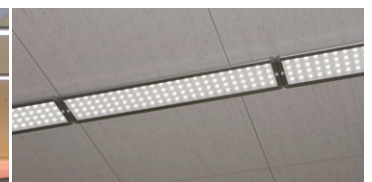
LEDベースライトストレートタイプを連続配置
