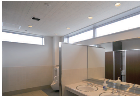
トイレの照明はLEDダウンライトと人感センサーによるON/OFF制御
