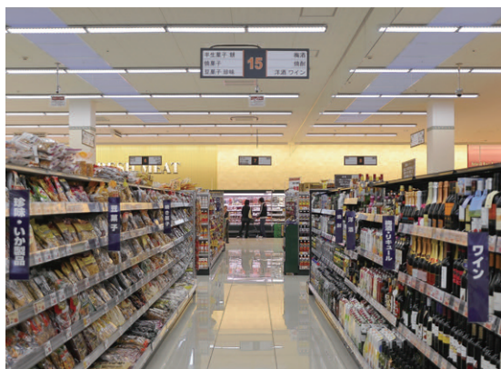
LEDベースライトストレートタイプは陳列棚と直角に配置し、均斉度をアップ
