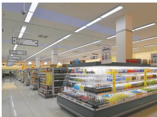
調光タイプを使用し、昼光利用制御で一定の明るさを確保しつつ、省エネを実現
