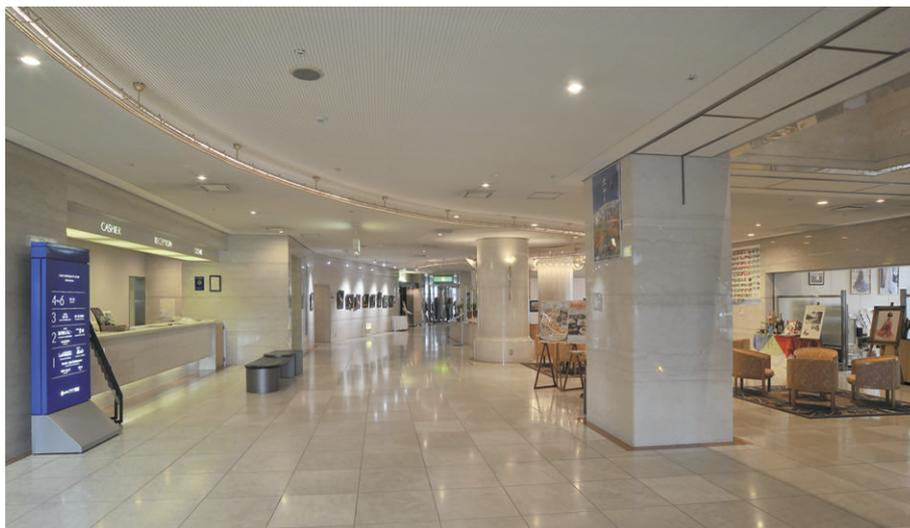
LEDダウンライトを中心に更新した1階フロント・ロビーの照明 適度な輝度コントラストにより落ち着いた雰囲気演出
