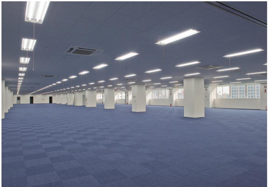
設計執務室の照明 均等配置した32WHf埋込開放器具をT/Flecsできめ細かく制御
