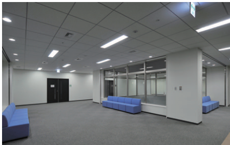
2階休息室の照明 蛍光灯埋込器具のほかソファ上への天井にLEDダウンライトを配置
