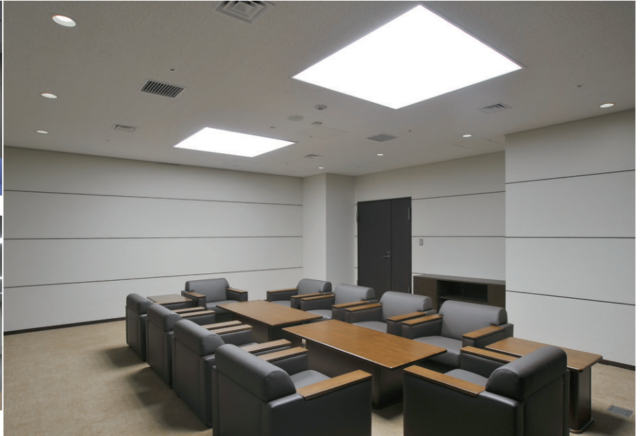
応接室の照明 FHF32W6灯用埋込カバー付器具とその周囲にLEDダウンライトを採用
