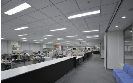
2階窓口・執務室のシステム天井用器具による照明
