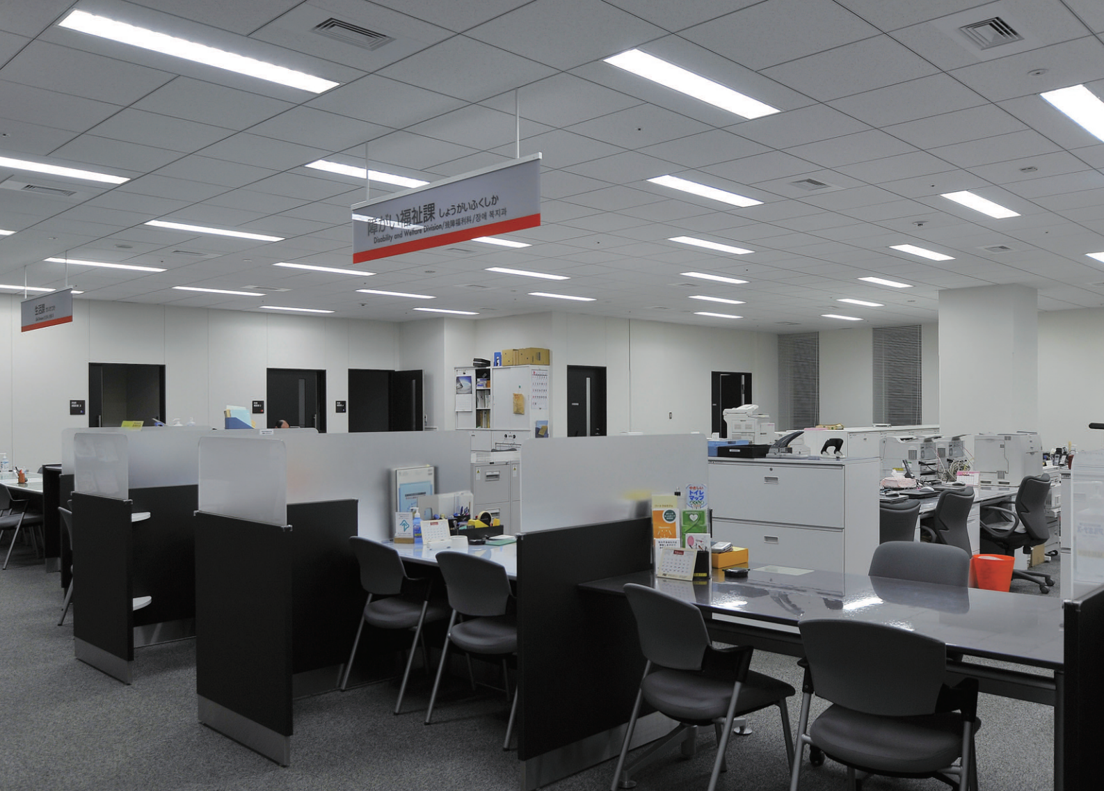
1階窓口・執務室の照明 システム天井用器具の千鳥配置で均斉度を高め、ルーバー付により目の負担を軽減
