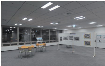
9階展示コーナー兼展望室の照明 レイアウト変更に容易に対応可能なグリッド天井システムを採用
