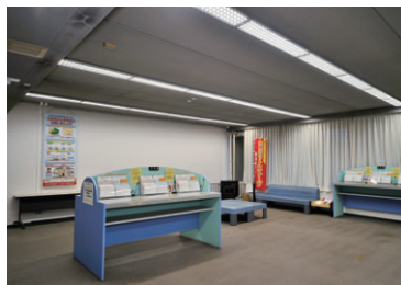
LEDベースライトストレートタイプによる窓口待合室の照明
