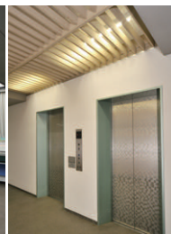
木製ルーバー天井内にLED照明を採用したエレベーターホール
