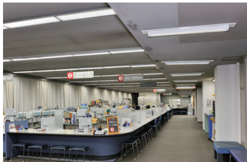
窓口通路部にはLEDベースライトスリムストレートタイプリニューアルプレート付を採用
