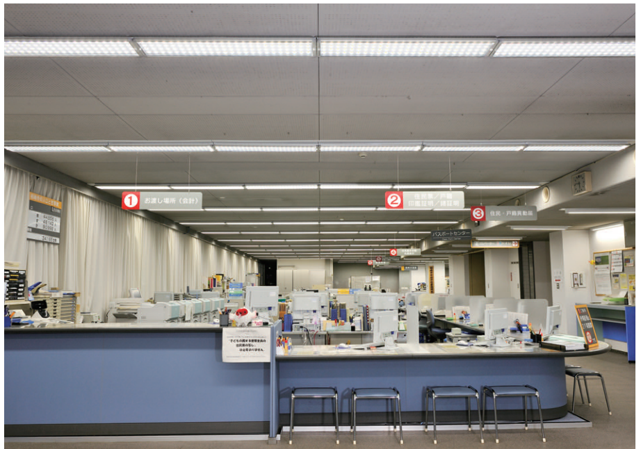
市民課窓口・執務室の照明 既存FLR40W器具からLEDベースライトストレートタイプに更新。照度アップしながら大幅なCO 2 排出量を削減
