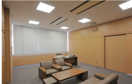
45Wコンパクト形蛍光ランプ3灯用スクエア器具を採用した町長室の照明
