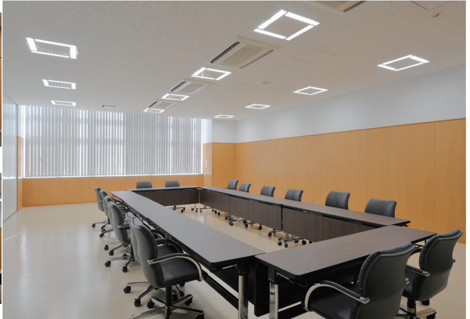
中会議室の照明 FHG70W1灯用スクエア器具バツフル付を採用し、グレアを抑えながら方向性のない執務空間を形成
