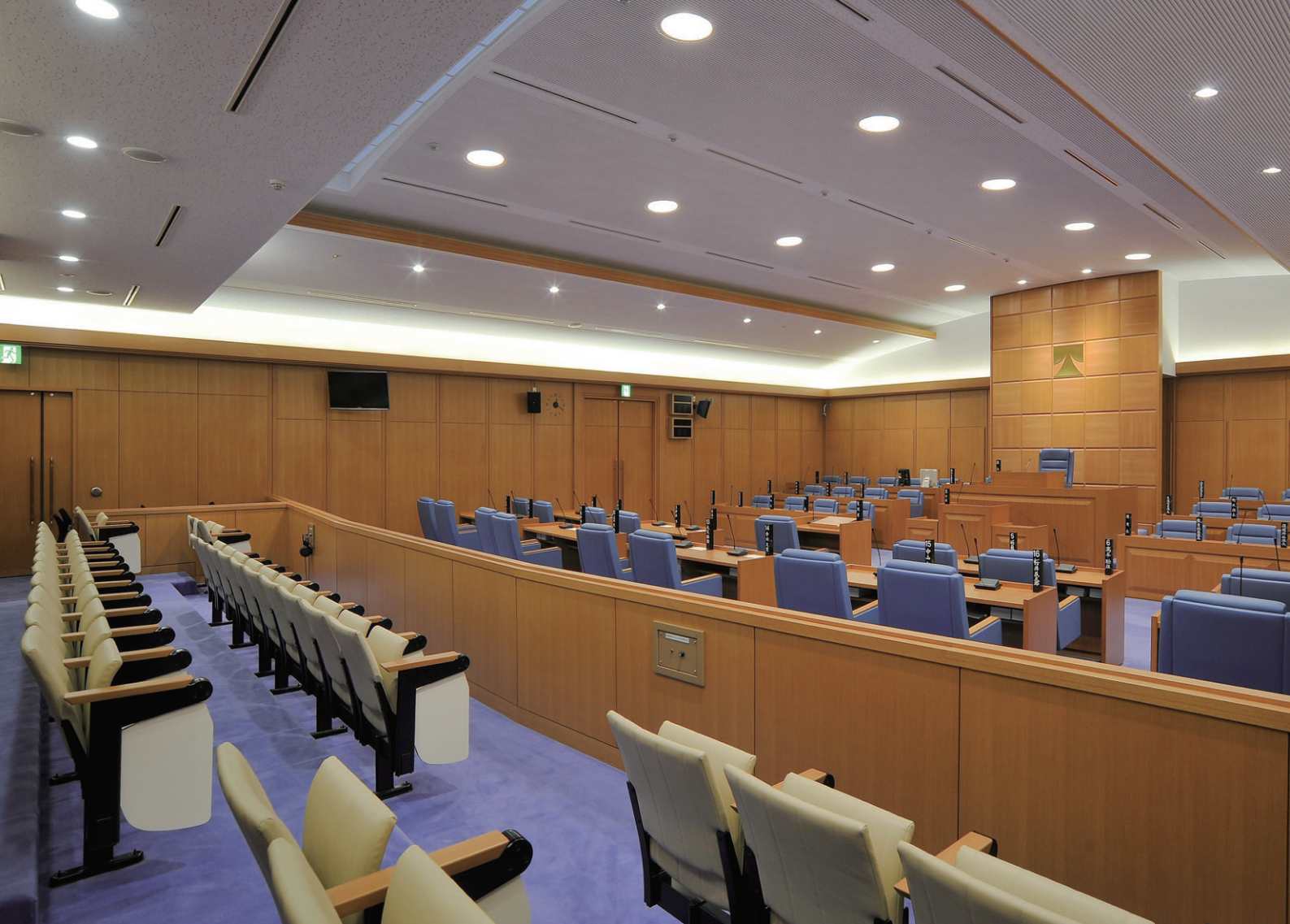
議場の照明 天井に高演色・高効率の100Wネオセラ<ブライト>ダウンライト調光形を採用し、木の温もりを損なうことなく、明るく一体感を形成。壁面は広がり感が高めるため間接照明としている
