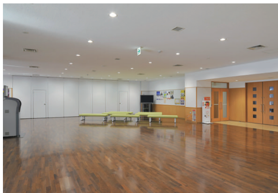
交流スペースの照明 100Wネオセラ<プライド>ダウンライトを均等配置し、和みある雰囲気を創出
