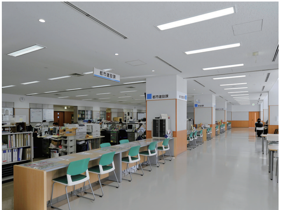
執務室の照明 Hf32W2灯用埋込器具OAルーバー付調光形を整列配置。照度センサーと連動で昼光利用制御と初期照度補正制御
