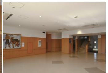
100Wネオセラ<プライド>ダウンライトによる議会ホールの照明
