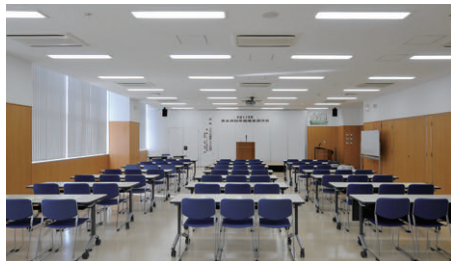
Hf32W2灯用埋込器具ベン皿乳白カバー付調光形を使用した大会議室の照明
