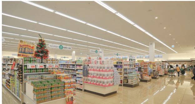
店内の照明 86WHf蛍光灯2灯用薄形直付連結器具をライン配置
