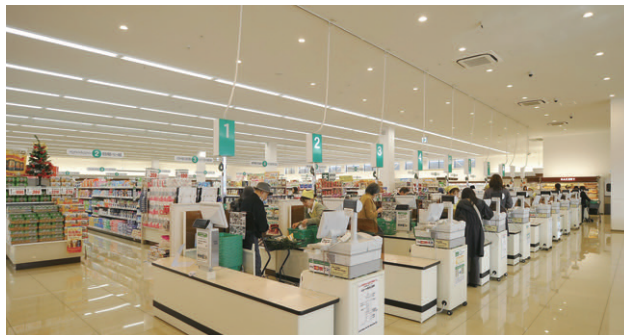
レジの照明 高演色（Ra85）LEDダウンライトでレジカウンター上の商品の色彩を美しく再現
