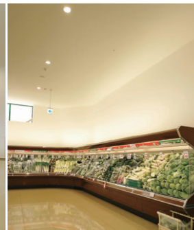
LEDダウンライト6000シリーズとアップライトによる回遊通路の照明
