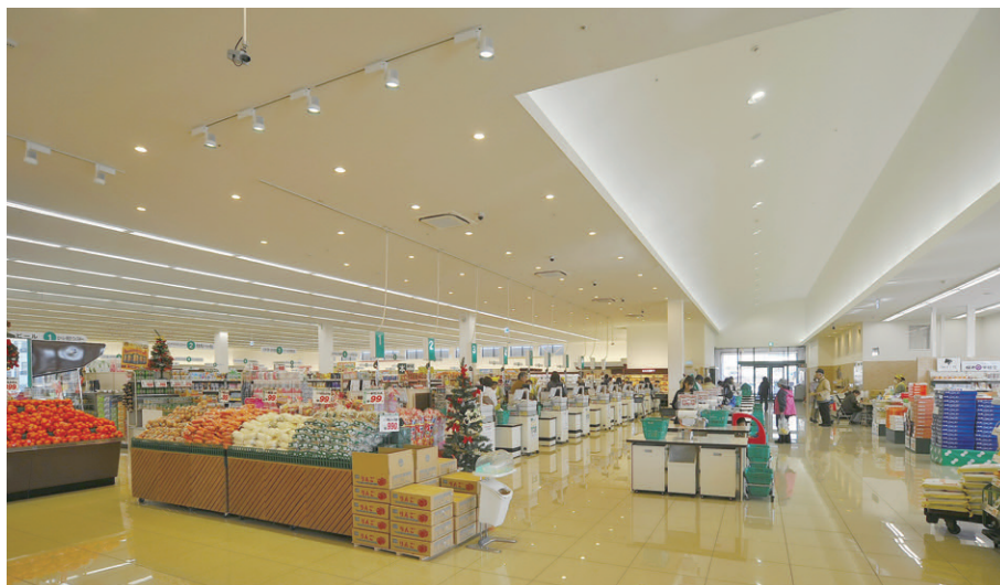
レジ・サッカー台周りの照明 斜め天井のHIDダウンライト（HL-ネオセラ）で地明かりを確保するとともに、間接照明による柔らかなあかりで親しみのある空間を創出
