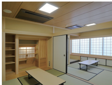
和室の照明 和室には和風埋込スクエア器具を、踏込みには和風ダウンライトなどを配置
