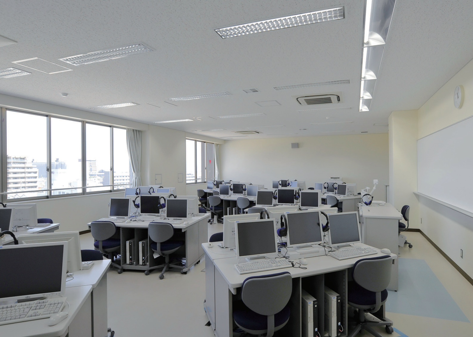
CALL教室の照明 省エネ蛍光灯器具エネカット32下面OAルーバー付を採用して、液晶モニターへの映り込みを防止し、生徒の目の健康に配慮
