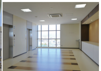
エレベーターホールの照明 FHP32W3灯用埋込器具調光形を配置
