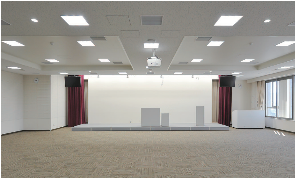
7階ホールの照明 FHP32W3灯用埋込器具及び調光形のLEDダウンライトで多目的に対応した演出を可能に
