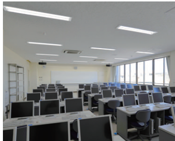
情報科教室の照明 省エネ蛍光灯器具エネカット32パツフル付を採用
