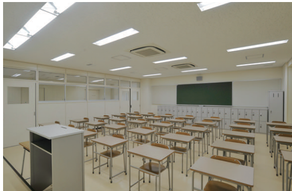
初期照度補正と長寿命かつ適切な視環境が得られる省エネ蛍光灯器具エネカット32を採用した普通教室の照明
