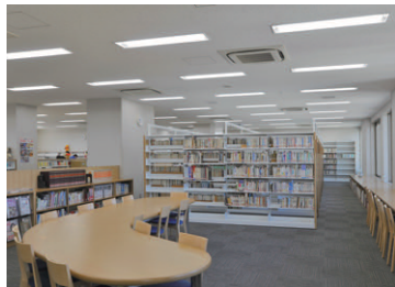
図書室の照明 省エネ蛍光灯器具エネカット32下面開放形を整理配置
