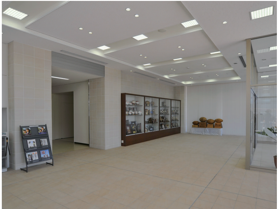
ロビーの照明 LEDベースライトスクエアタイプとLEDダウンライトを使用
