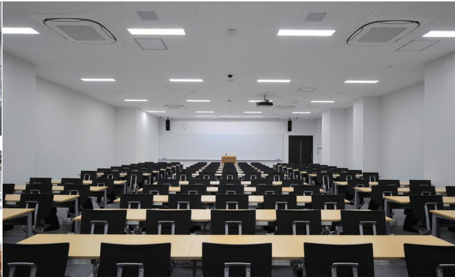
2階講義室の照明 LEDベースライトストレートタイプを採用し、あかりセンサーを設け、初期照度補正及び昼光利用制御でさらなる省エネを実現
