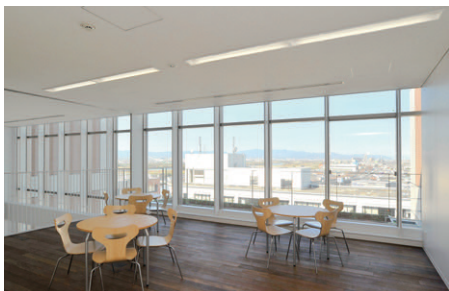
各階に設けられているコミュニケーションコーナーにはFHF32 W埋込器具2連結を採用
