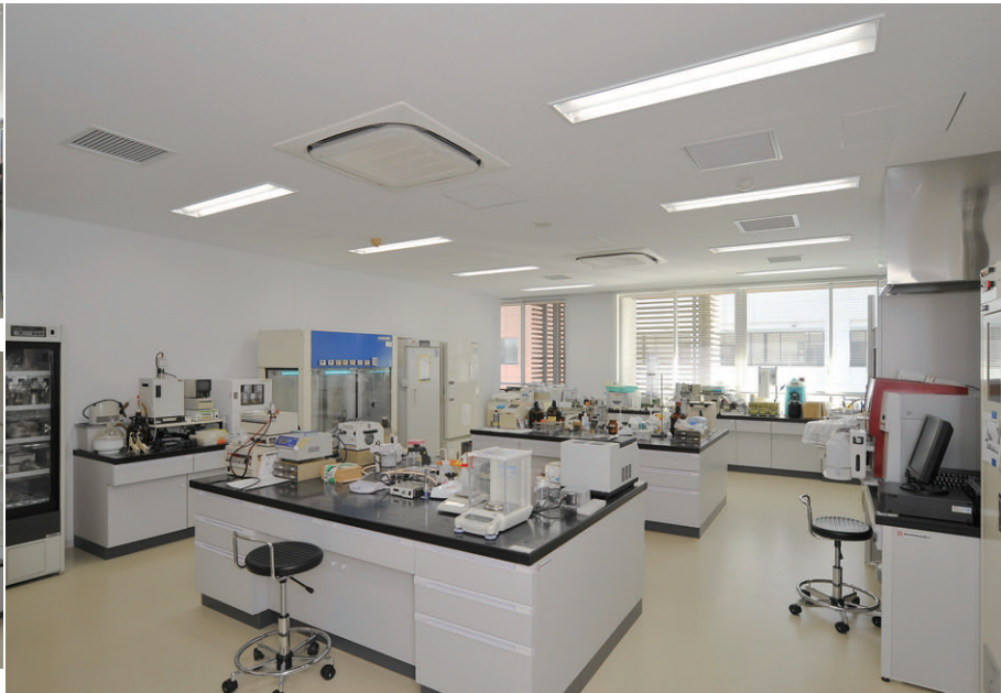
8階の生命科学研究室の照明 エネカット32+<プラス>2灯用埋込器具を採用(平均照度700lx)
