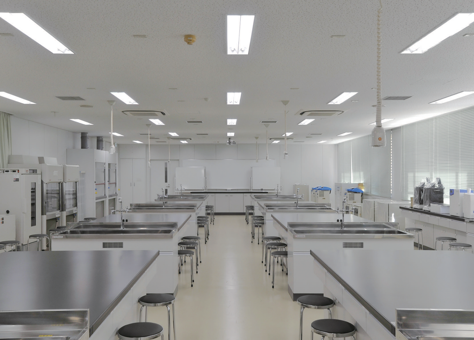
8階の生命科学研究室の照明 施設用ベース照明エネカット32+<プラス>2灯用埋込器具初期照度補正タイプを整列配置(平均照度700lx)
