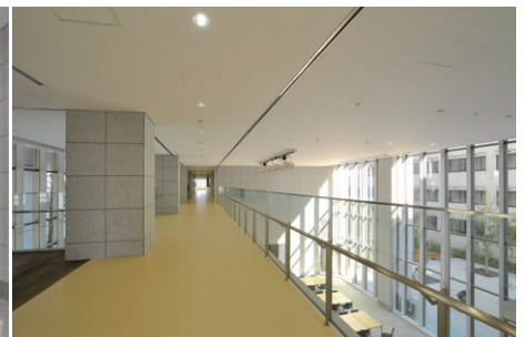
吹抜け空間が望める2階通路の照明は57Wコンパクト形蛍光灯ダウンライトを使用
