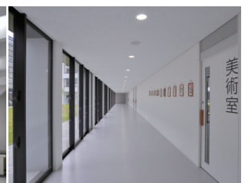
FHT32Wダウンライトによる廊下の照明
