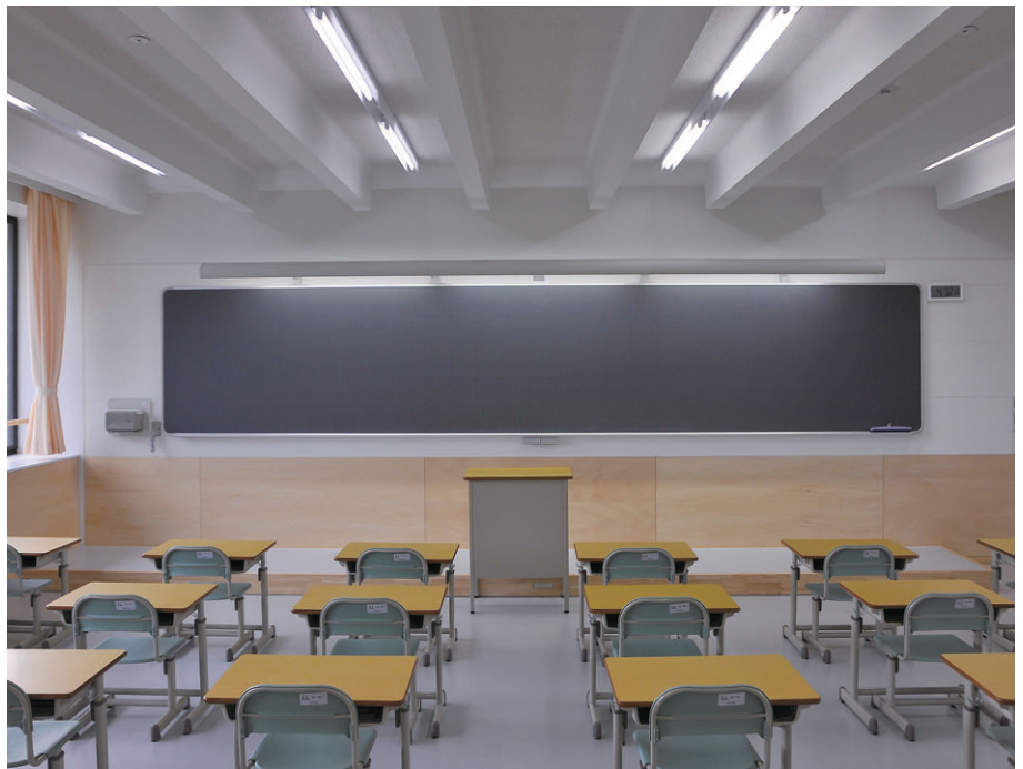
普通教室の照明 凹凸意匠の天井に初期照度補正機能付のFHF32W1灯用トラフアクリルカバー付(特注)を採用
