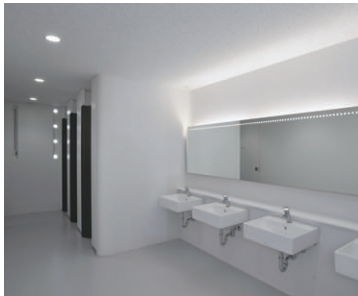
LEDダウンライトと間接照明のトイレの照明
