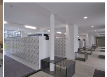
人感センサー連動のFHT32Wダウンライトと間接照明による昇降口周り
