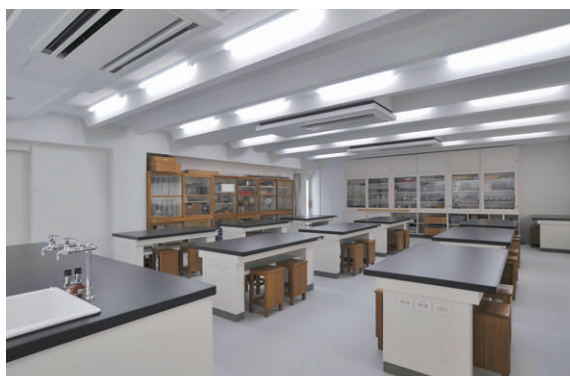
黒板に平行に配置した初期照度補正機能付のFHF32W1灯用トラフアクリルカバー付(特注)を設置した生物室
