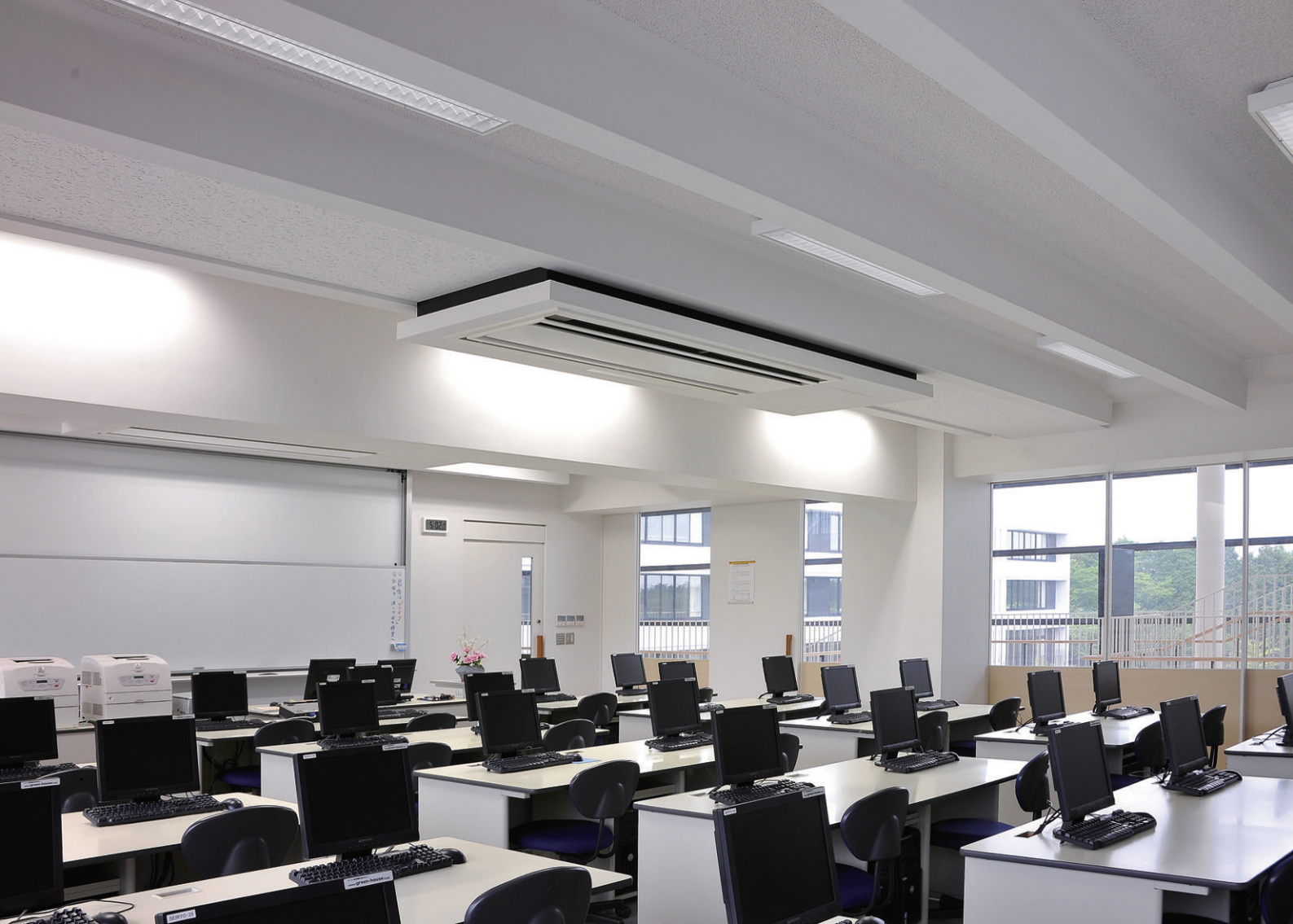
パソコン教室の照明 FHF32W2灯用直付器具OAルーバー付初期照度補正タイプを採用し、生徒の目の健康を守りながら省エネ
