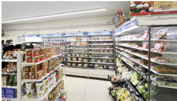
冷蔵品・日配品売場の照明 光が拡散する半月形カバー付のLEDベースライトを設置して壁際の明るさを確保し、安心感のある売場を演出
