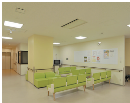
不安感を軽減するため蛍光灯埋込スクエア器具のカバー付を採用した待合室
