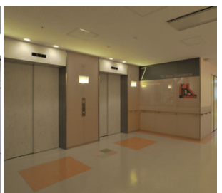
エレベーターホールの照明
