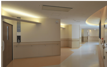
間接照明を主とした廊下の照明
