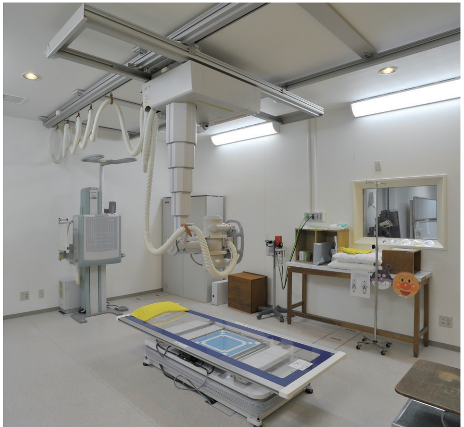
放射線科の照明 蛍光灯のコーナー器具で地あかりを確保し、電球形蛍光灯ダウンライト調光形で検査内容に応じた調光を可能
