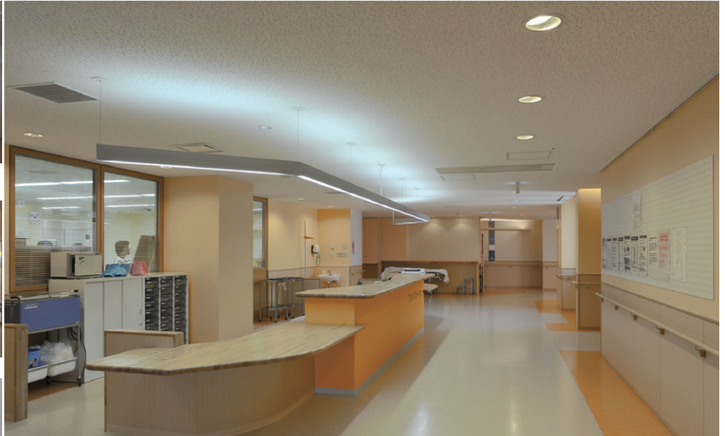
スタッフステーションの照明 カウンター前の廊下はLEDダウンライトとウォールウォッシャーダウンライトを、カウンター上は上下配光形蛍光灯器具を、奥のスタッフルームには初期照度補正タイプの蛍光灯埋込カバー付器具をライン配置
