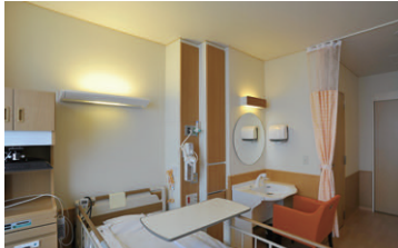
病室の照明 ベースにコーニス間接照明、ベッド頭上部にはホスピタルプラケットを採用
