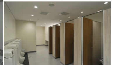
トイレのLEDダウンライト照明
