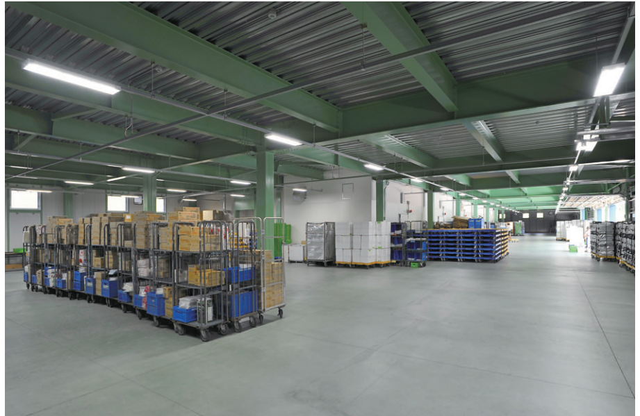
広い面積の商品倉庫にはLED一体形ベースライト直付形ストレートタイプを採用
