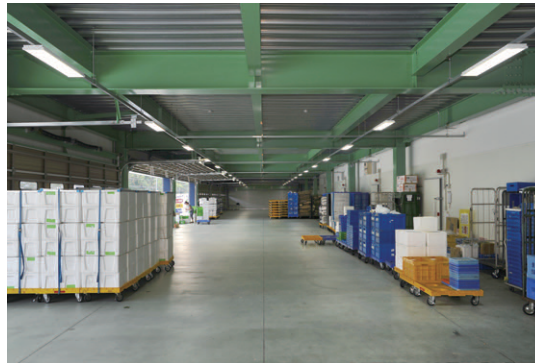
LED一体形ベースライトは床3.5mに設けたレースウェイに設置
