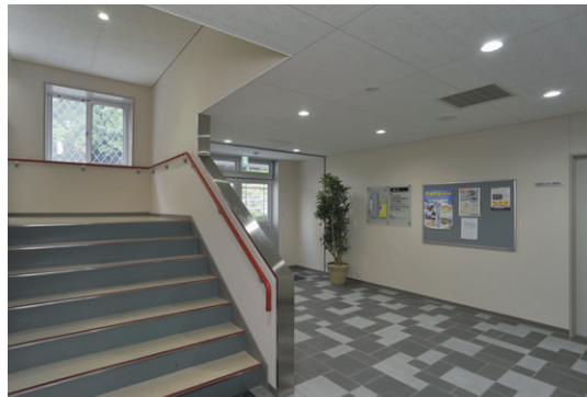
玄関ホールおよび廊下にはLEDダウンライトを均等配置
