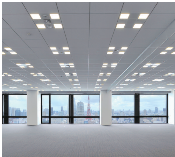
事務室内部から外周ゾーンを望むグリッドシステム天井用LEDベース照明
