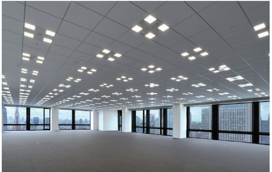
基準階オフィスフロアに採用されたグリッドシステム天井用LEDベース照明器具を均等配置。昼光利用制御や人感センサーによる入室検知制御でムダな明るさをカットして適正照度を確保
