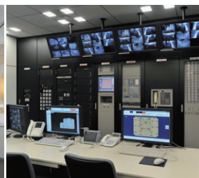
中央管理室の照明制御監視システム
