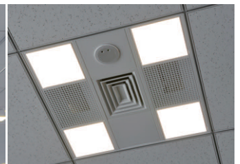
600mm角照明器具面の9分割のうち4面にLEDモジュールを配置
