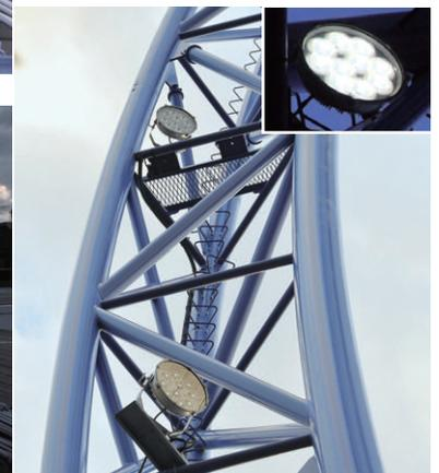
防球ネット用サイド鉄塔に設置されたLED投光器（器具高さ16mと11mの2か所）
