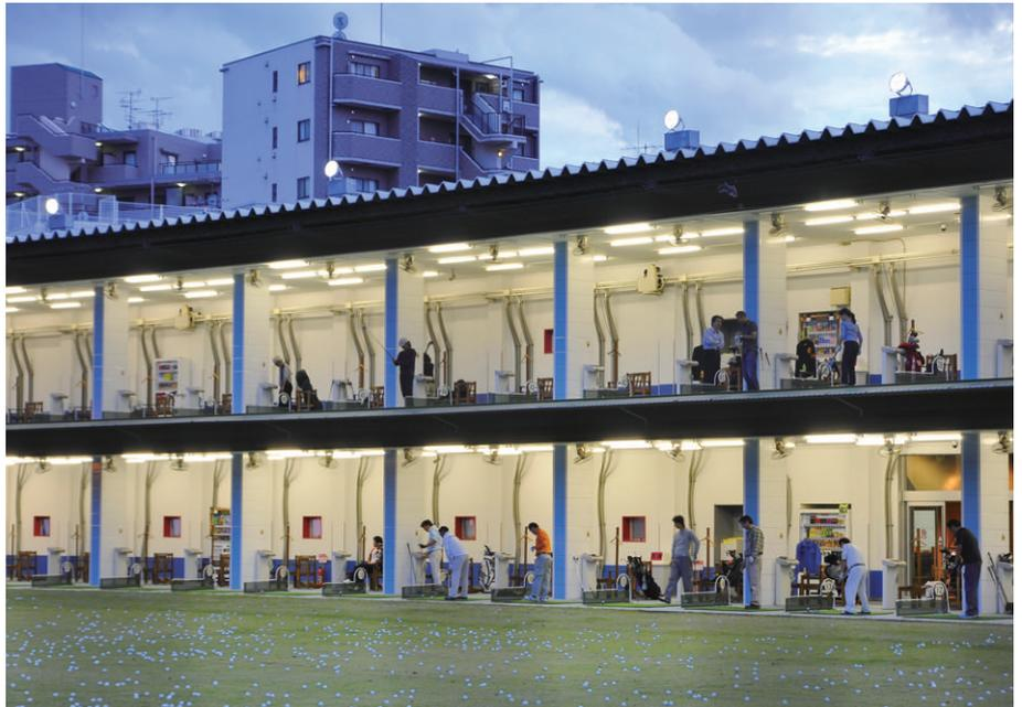
2階の打席底上部（器具高さ10m）に更新したLED投光器をほぼ均等に8台配置
