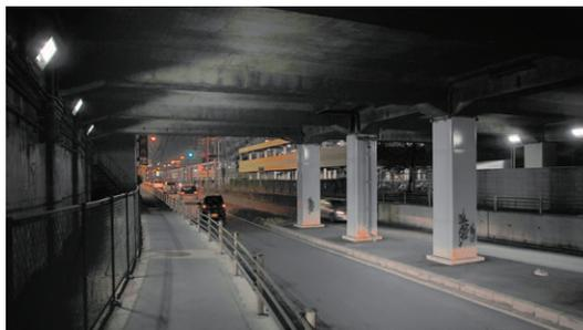
アンダーパス内の両側壁上部にLEDトンネル照明器具を均等に配置
