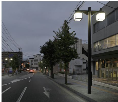
千鳥配置で設けられているLEDの歩道灯
