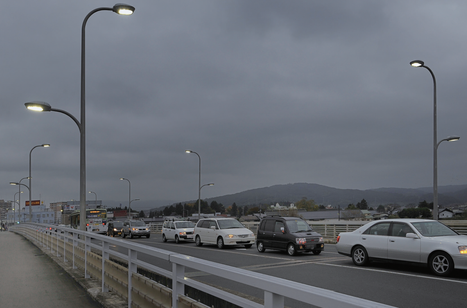
LED道路灯とLED歩道灯を配備した明治橋の橋梁照明。車道灯は路面平均照度40lxを得ており、視認性と誘導性のよい橋梁道路環境を確保しながら省エネ性能を発揮
