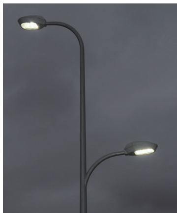
LED道路灯とLED歩道灯を配備した夜間点灯時の橋梁道路灯
