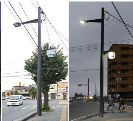
LED車道灯とLED歩道灯を配備した10mデザインポール
