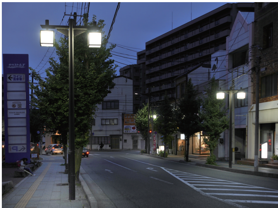
一般県道不動盛岡線の南大通り二丁目付近に設けられている更新されたLED歩道灯
