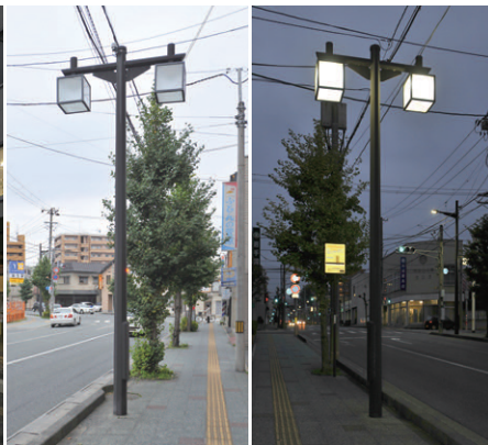
市街地空間と調和したLED歩道灯5mポール
