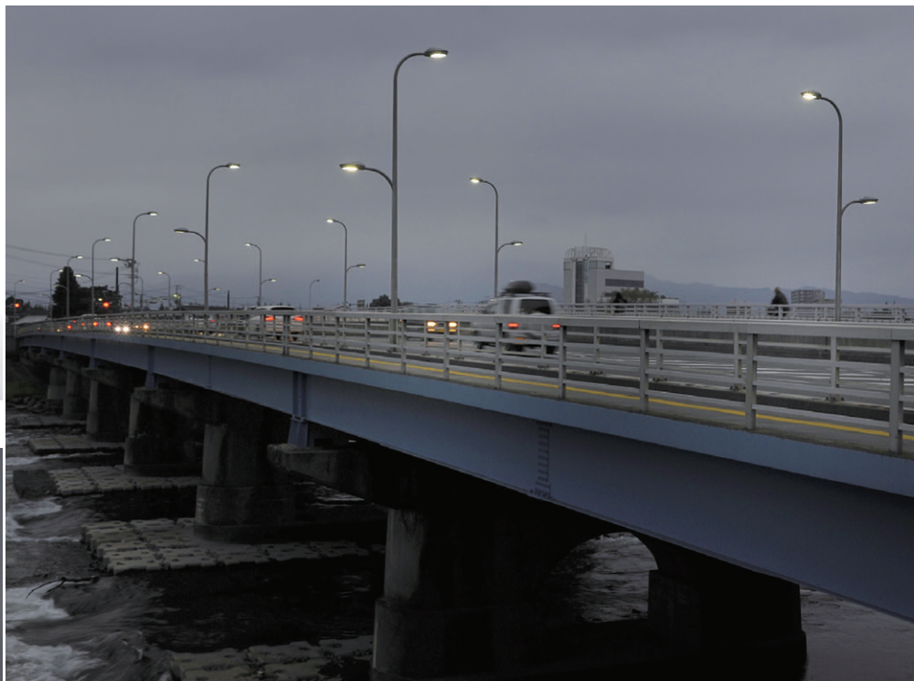
明治橋のLED橋梁道路照明の外景。LED道路灯は24mピッチで向き合わせ配列
