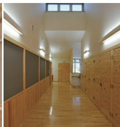
2階廊下には遮光タイプセード可動形ブラケットを採用
