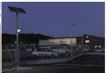
屋外の出入口にはソーラー式外灯を配置
