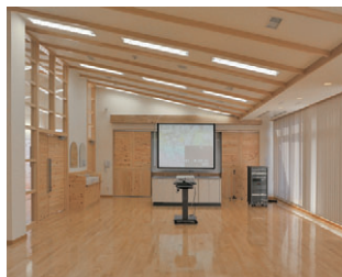
遮光角制御形埋込器具を採用した食堂兼会議室の照明
