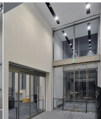
エントランスのLED照明
