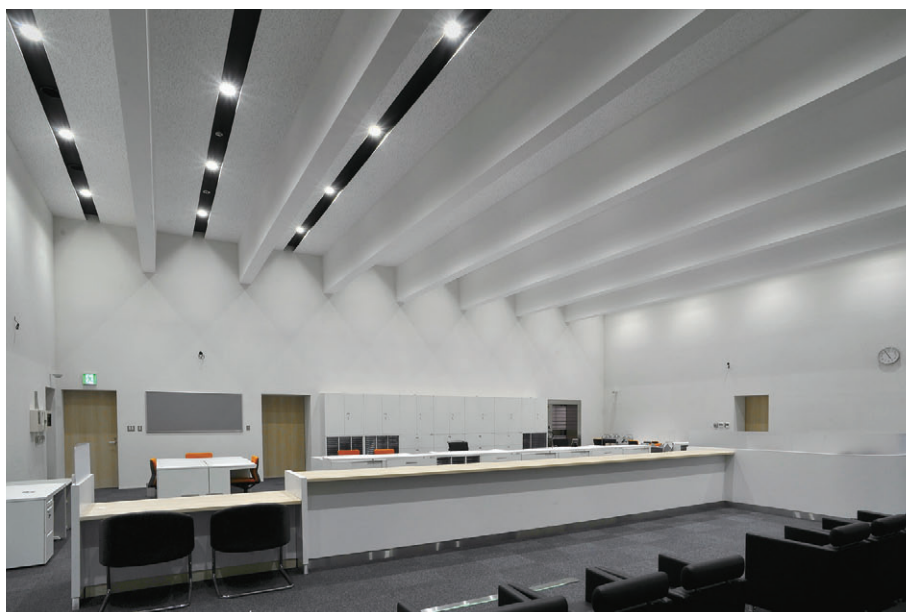
エントランス方向の客溜り側から執務室方向を望む照明 PC梁と各梁間にLEDダウンライト9000シリーズを配置
