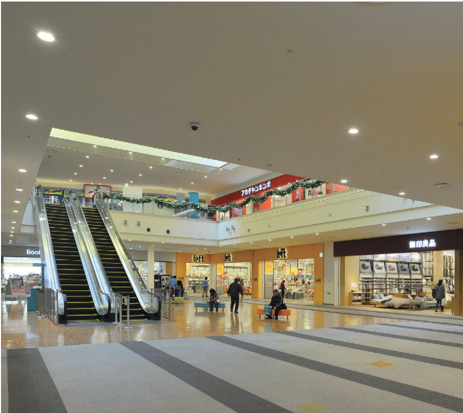
モール部の照明(1) エスカレーター周辺の吹き抜けを囲むようにLEDダウンライト6000シリーズを配置
