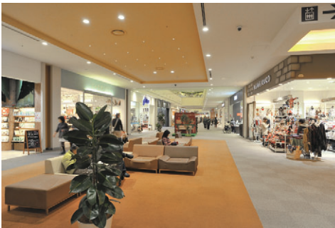
ショッピング通路の照明 店舗前の平天井部と折上天井部にLEDダウンライトを配置
