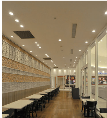
テーブル上と壁際にLEDダウンライトを配置した飲食コーナーの照明
