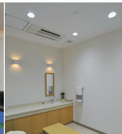
LEDダウンライトと人感センサーとの連動でON/OFF制御
